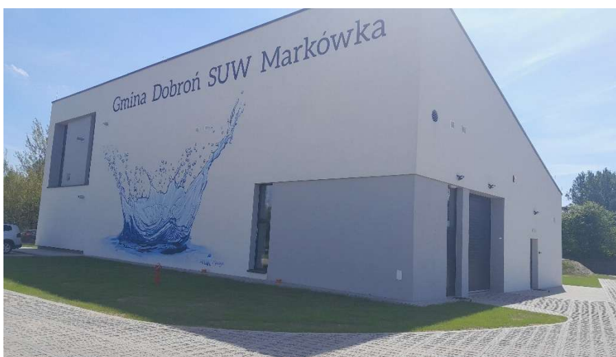
Zdj. 1 – budynek SUW w Markówce
