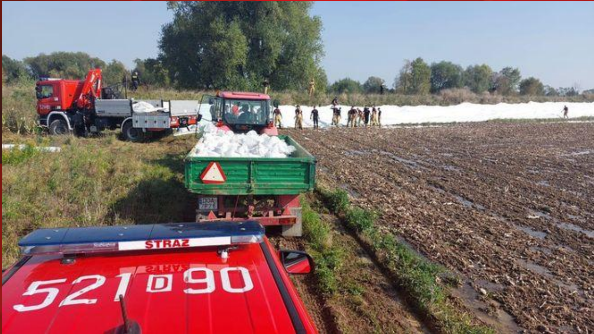
Rysunek 2 Umacnianie wałów przy ul. Rybackiej w Oławie (źródło: https://jelenia-gora.eska.pl/galeria/olawa-przygotowuje-sie-do-fali-powodziowej )
