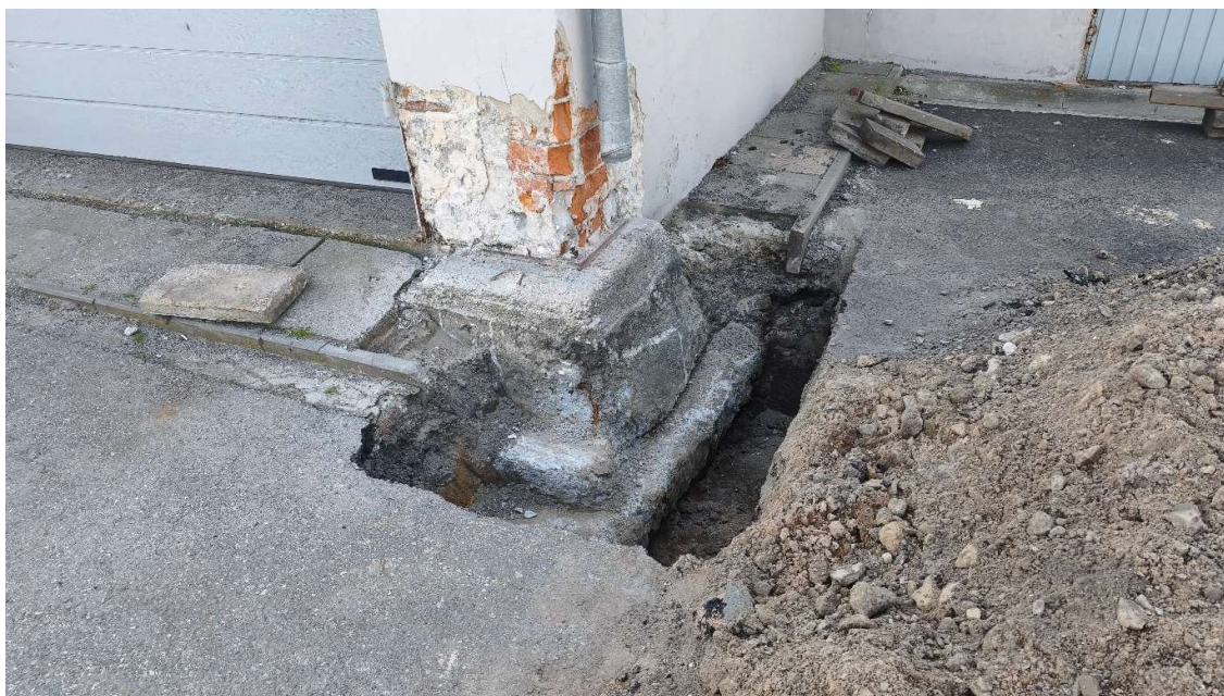
Fot. Stopa fundamentowa – odkrywka
