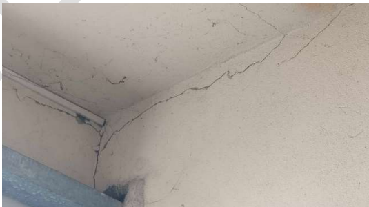
Rys. schematyczny przebieg zarysowań na ścianie wewnętrznej, poprzecznej
