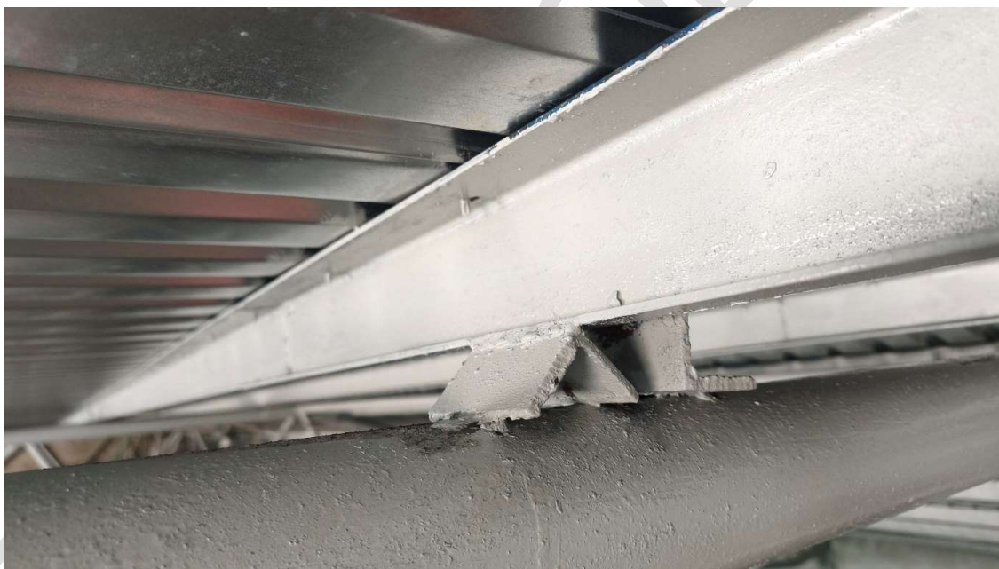
Fot. Fragment konstrukcji stalowej dachu
