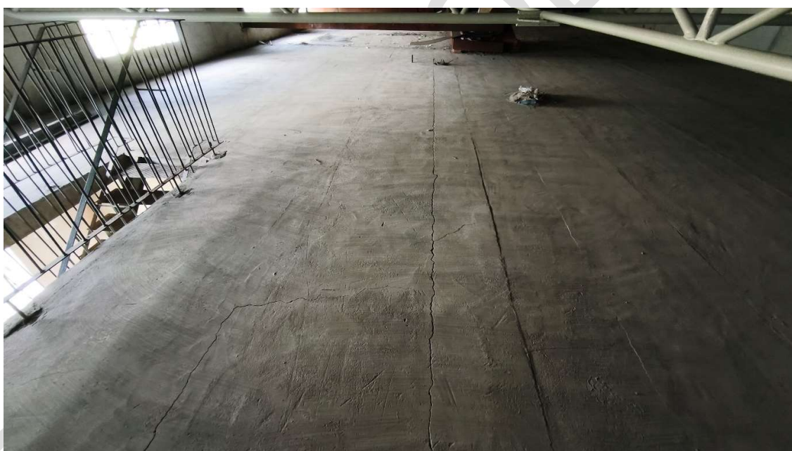
Fot. Strop – widok od góry
