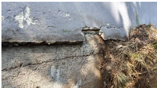
Fot. Miejsce wykonania odkrywki nr 2 – ława fundamentowa/podwalina
