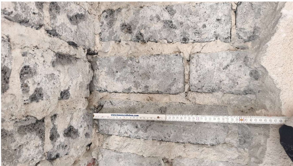
Fot. Odkrywka – mur z pustaka żużlowo-betonowego
