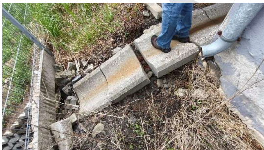
Fot. Zdegradowane utwardzenia i części kanalizacji
