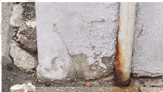
Fot. Zdegradowane utwardzenia i części kanalizacji
