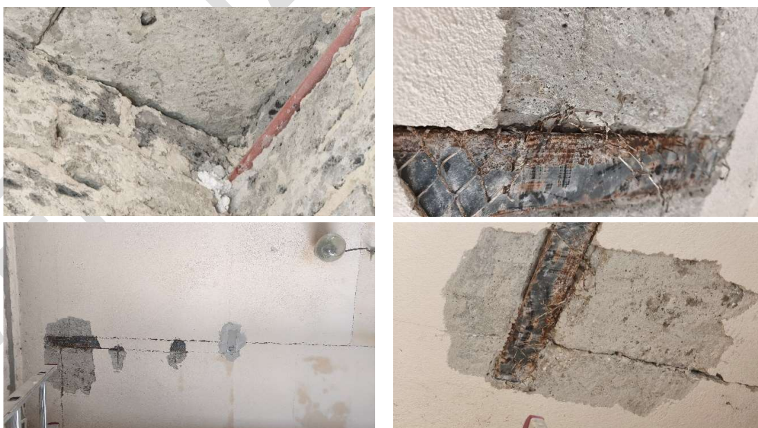
Fot. Odkrywki stropu od dołu
