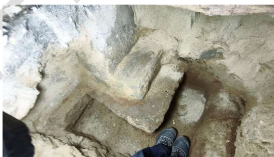
Fot. Miejsce wykonania odkrywki nr 1 – stopa fundamentowa
