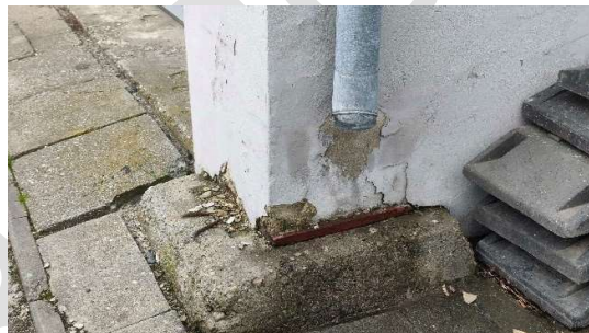
Fot. Uszkodzenia kanalizacji deszczowej obiektu oraz odprowadzenie na tereny nie utwardzone
