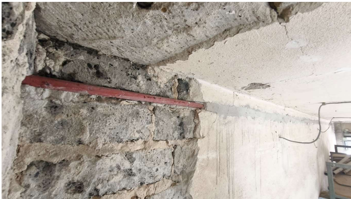
Fot. Odkrywka – ścią stalowy w ścianie poprzecznej
