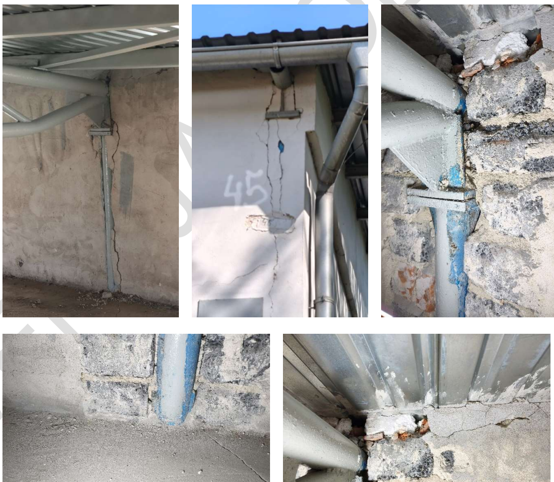
Fot. Odkrytki ścian murowych z pustaka żużłobetonowego wraz z widocznymi zarysowaniami
