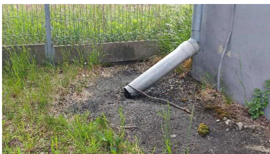
Fot. Uszkodzenia kanalizacji deszczowej obiektu oraz odprowadzenie na tereny nie utwardzone
