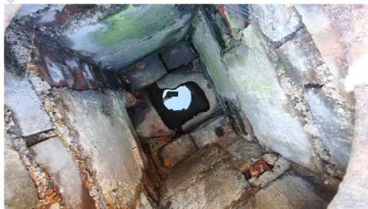
Fot. Uszkodzenia kanalizacji deszczowej obiektu oraz odprowadzenie na tereny nie utwardzone
