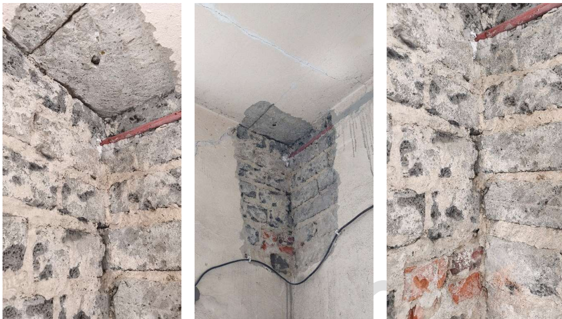
Fot. Odkrytki ścian murowych z pustaka żużłobetonowego wraz z widocznymi zarysowaniami
