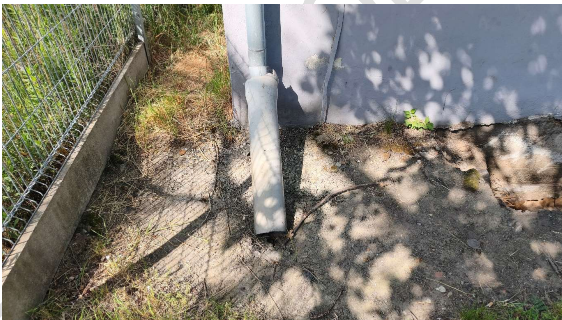
Fot. Odprowadzenie wód opadowych w strefę przy obiekcie
