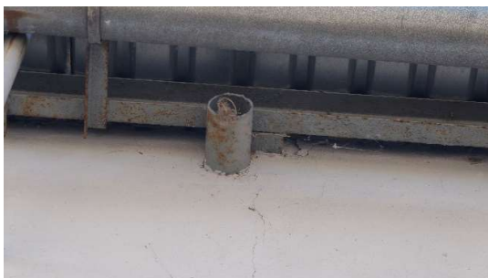
Fot. Korozja podstaw słupów stalowych i cz. konstrukcji dachu + jakość spawów
