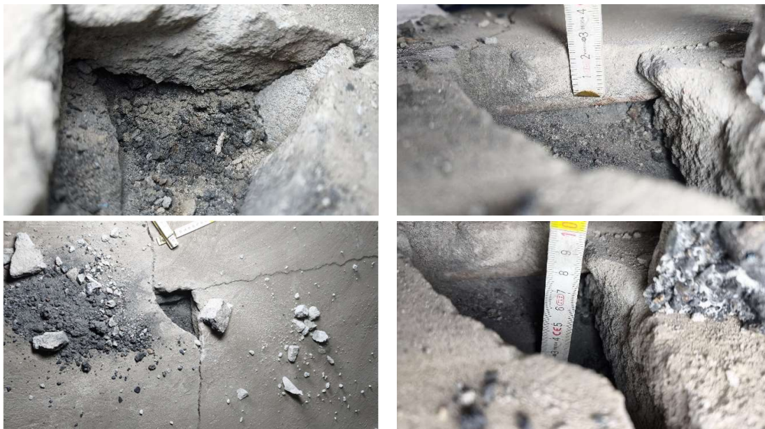
Fot. Odkrywki stropu od góry
