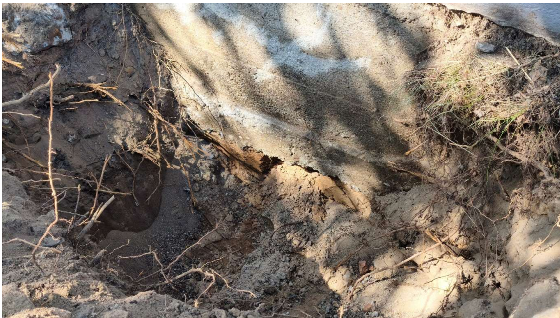
Fot. Ława fundamentowa – odkrywka
