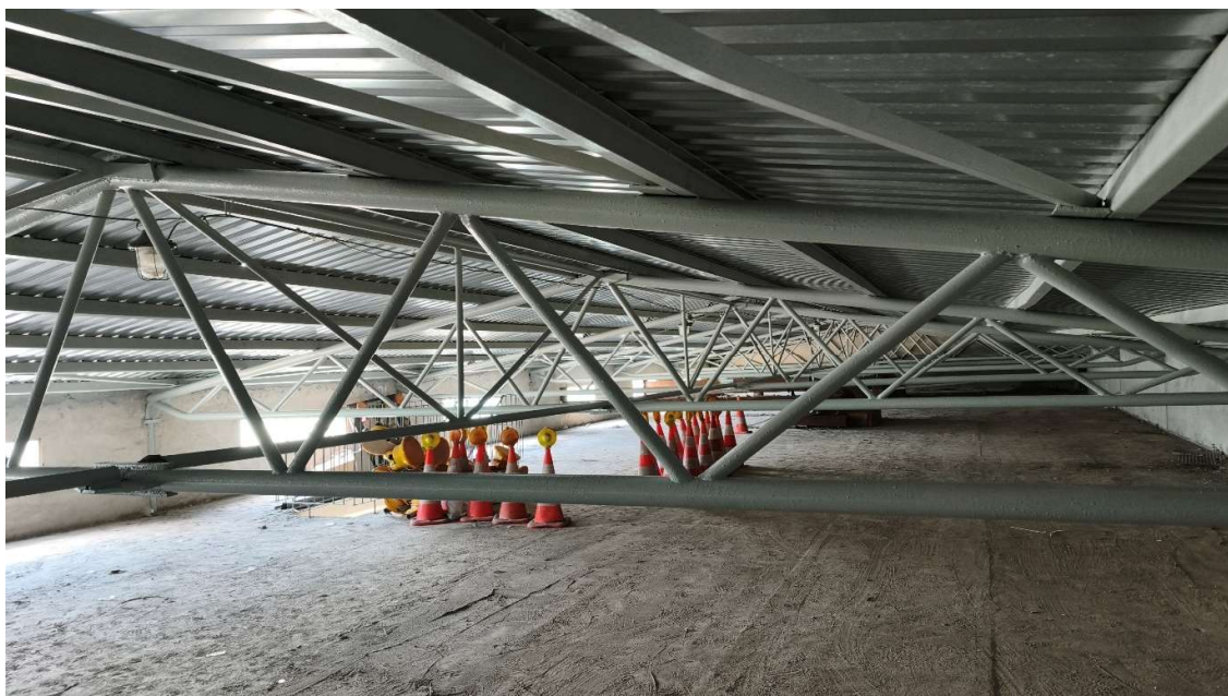
Fot. Konstrukcja dachu oraz strefa wyższej kondygnacji
