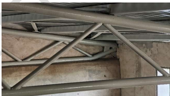
Fot. Korozja podstaw słupów stalowych i cz. konstrukcji dachu + jakość spawów
