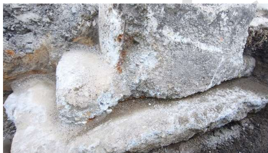
Fot. Miejsce wykonania odkrywki nr 2 – ława fundamentowa/podwalina
