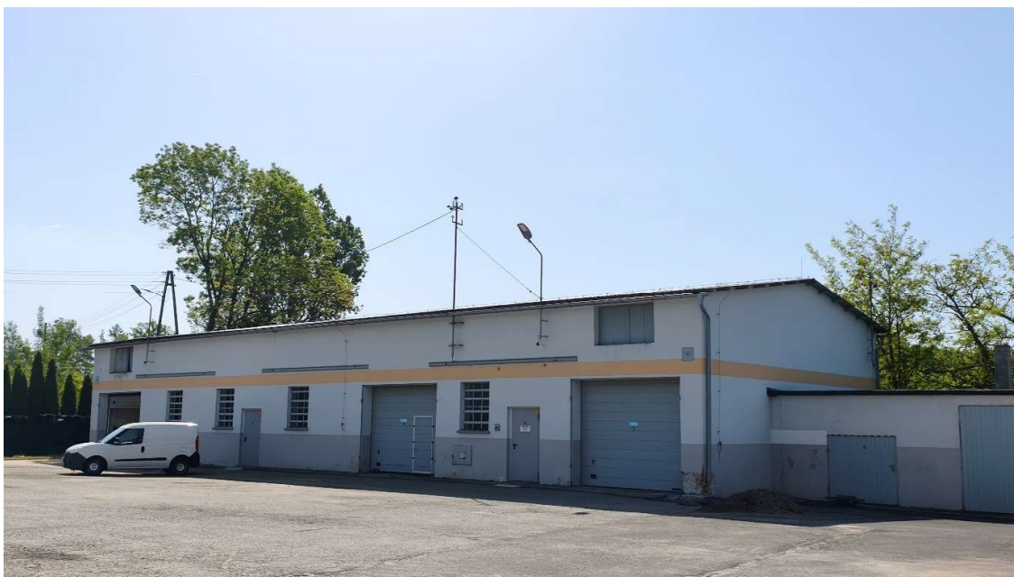
Fot. Przedmiotowy obiekt – widok od strony działki Inwestora
