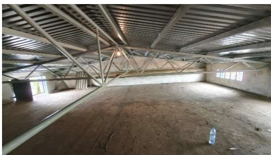
Fot. Korozja podstaw słupów stalowych i cz. konstrukcji dachu + jakość spawów
