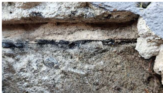
Fot. Miejsce wykonania odkrywki nr 2 – ława fundamentowa/podwalina
