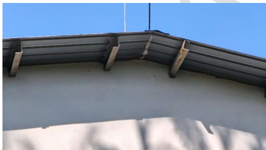
Fot. Korozja podstaw słupów stalowych i cz. konstrukcji dachu + jakość spawów
