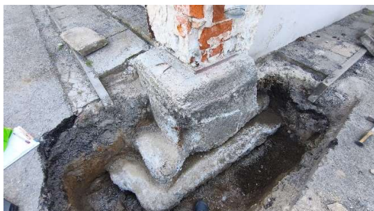
Fot. Miejsce wykonania odkrywki nr 2 – ława fundamentowa/podwalina
