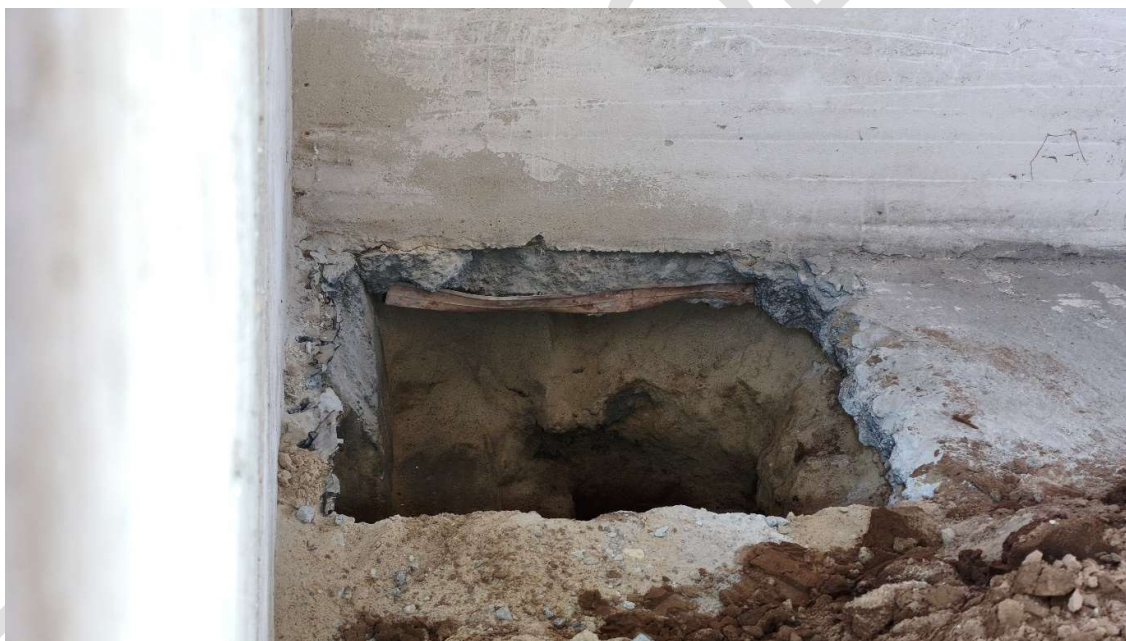
Fot. Posadzka - odkrywka
