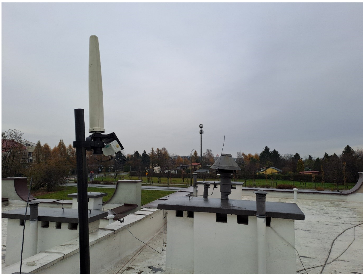
Rys. 3 Miejsce montażu SMS PEM – Jubilat – Dom Kultury, Tarnowskie Góry – widok na SBTk
