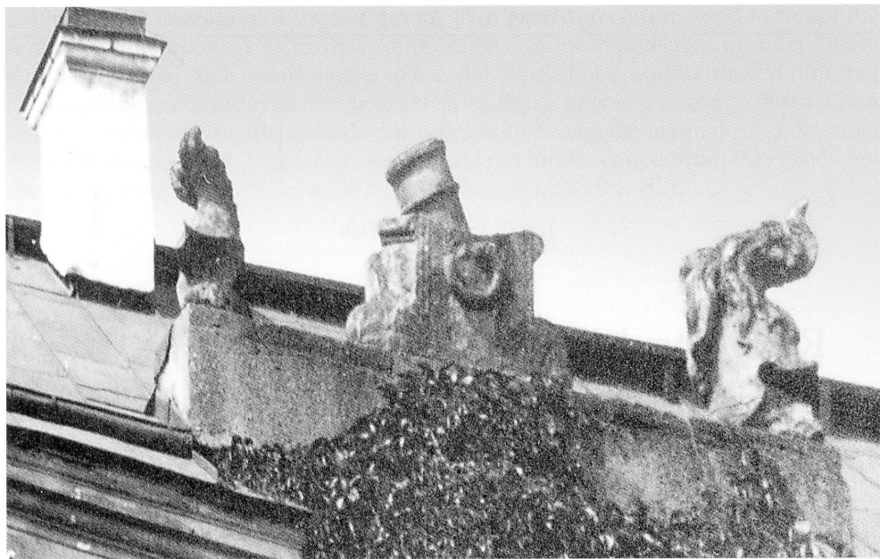
1. Fragment zdjęcia z roku 1920, przedstawiający kompozycję rzeźbiarską na elewacji budynku Arsenалу przy pałacu Branickich w Białymstoku. Autor nieznany. Fragment of an archival photograph from the 1920s with a sculpted composition of the elevation of the Arsenal next to the Branicki Palace in Białystok. Author unknown.
