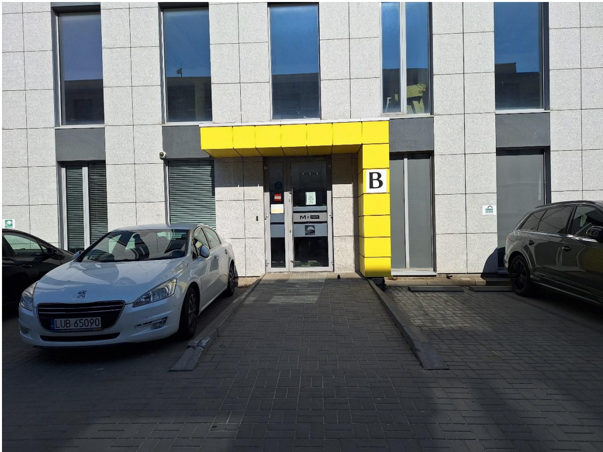
wejście główne do budynku
