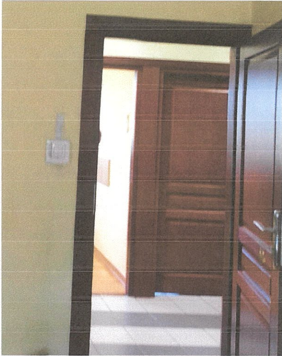
Częściowy widok pokoju biurowego z wyjściem na korytarz do przebudowy na WC dla osób z niepełnosprawnością
