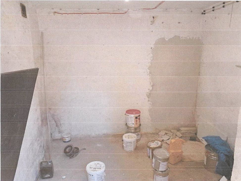
Pomieszczenie magazynu – zacienione miejsce na ścianie – zamurowany otwór drzwiowy do wykucia
