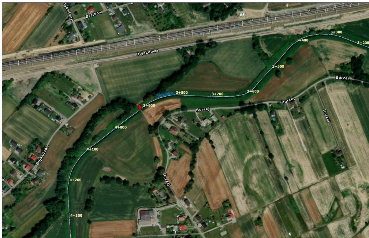
Rys. 9 Lokalizacja uszkodzenia prawego wału przeciwpowodziowego na rzece Iłownicy.
