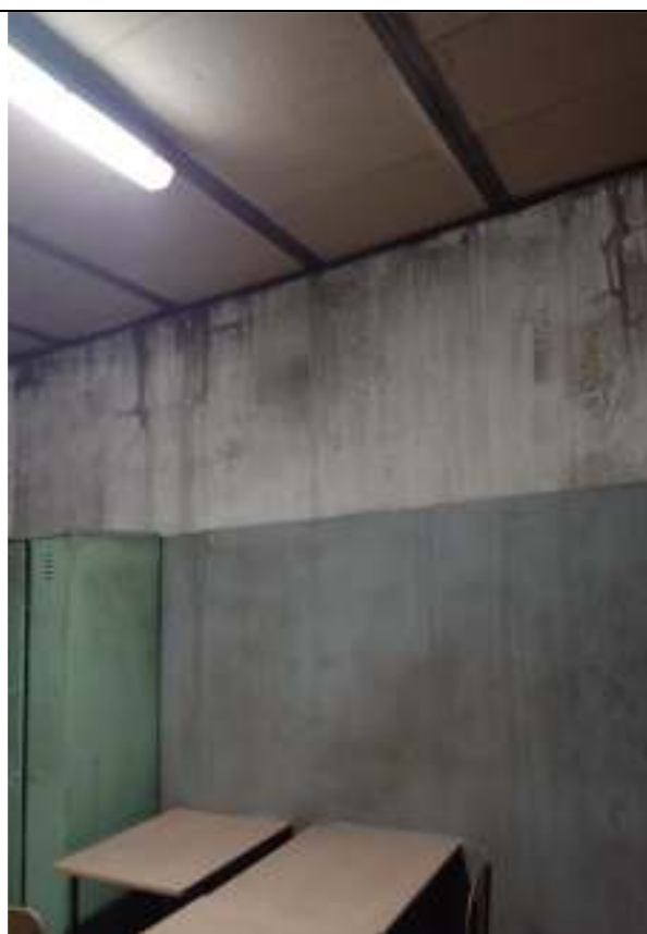
Pomieszczenie jadalni dla pracowników
