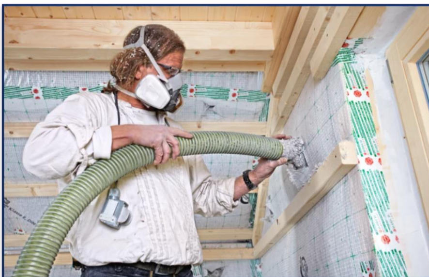
fot. 3 onet.pl: wdmuchiwanie włókien celulozowych
