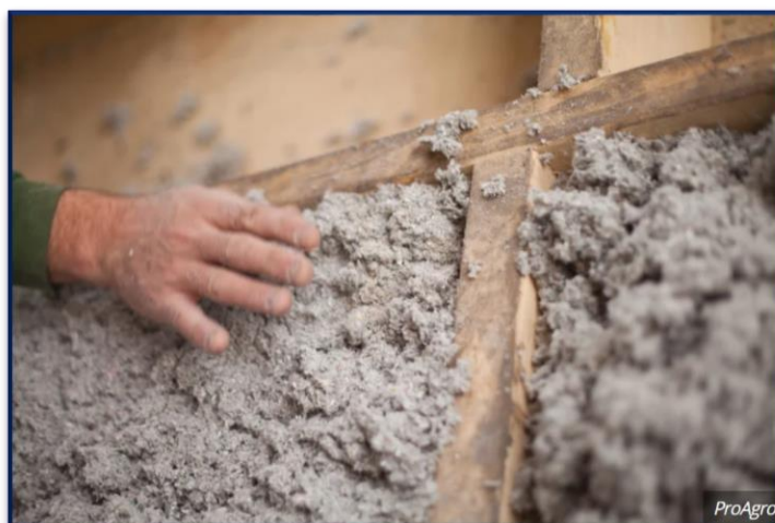
fot. 1 jak budować: ocieplenie wełną celulozową
