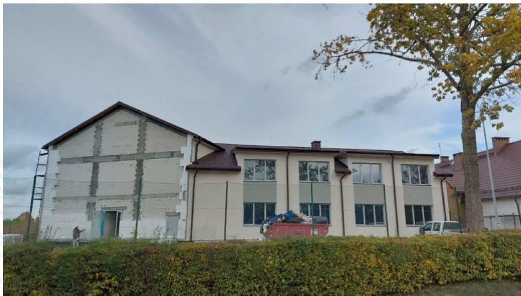
Graf. 12. Budowa hali sportowej w Wilanowie
