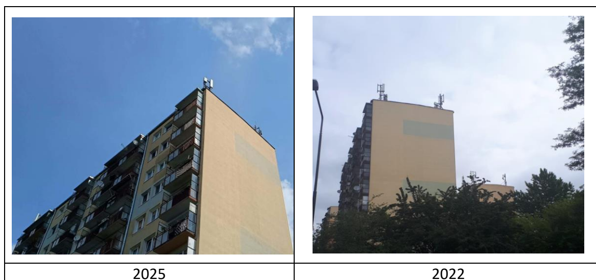
Rys. 10: Widok anten stacji bazowej – ID: 29067
