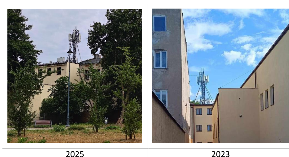
Rys. 6: Widok anten stacji bazowej – ID: 29770
