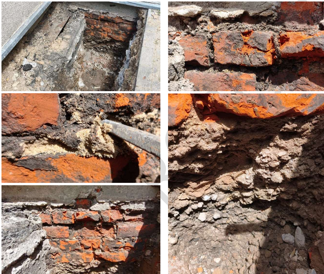
Fot. ława fundamentowa
