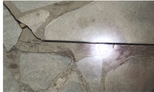
Fot. Zarysowania powstałe na posadzce budynku świetlicy – przedmiot opracowania
