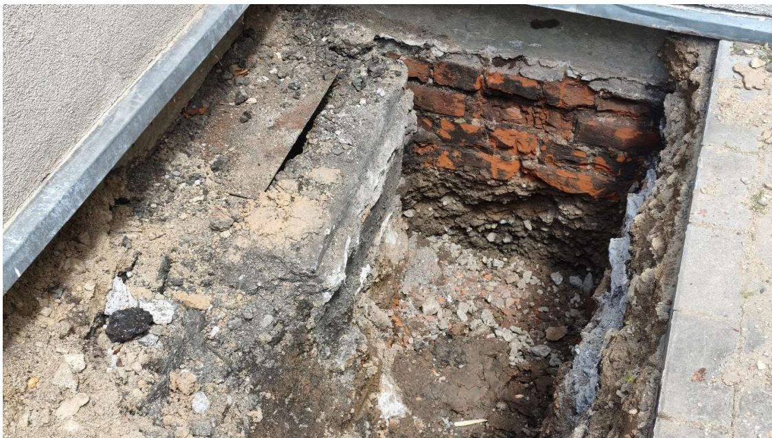
Fot. Odkrywka fundamentów
