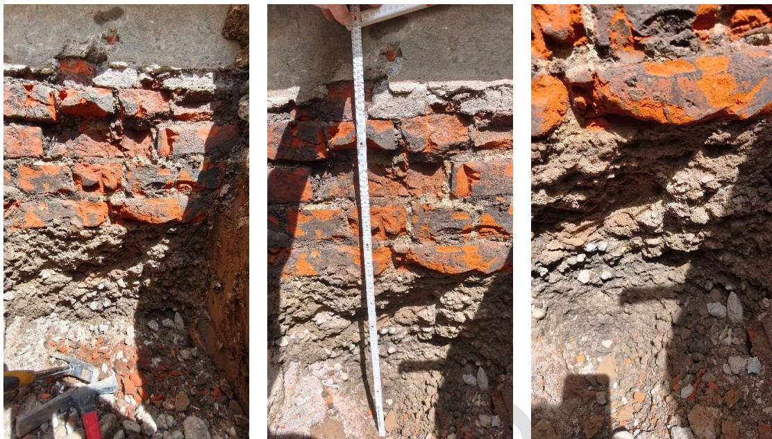
Rys. Warstwy ławy fundamentowej
