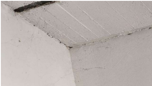
Fot. Zarysowania na ścianach i na styku ściany ze stropem
