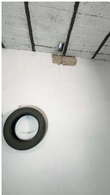
Rys. Zarysowania pod belkami stalowymi
