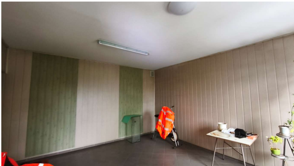
Fot. Pomieszczenia socjalne – I piętro
