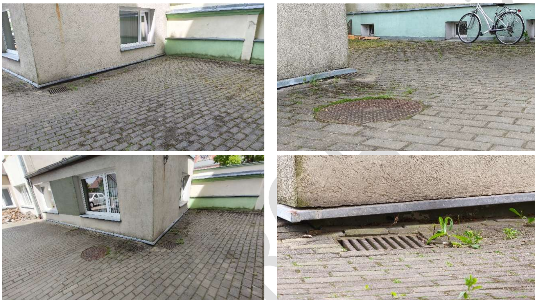
Fot. Ściana od strony południowej
