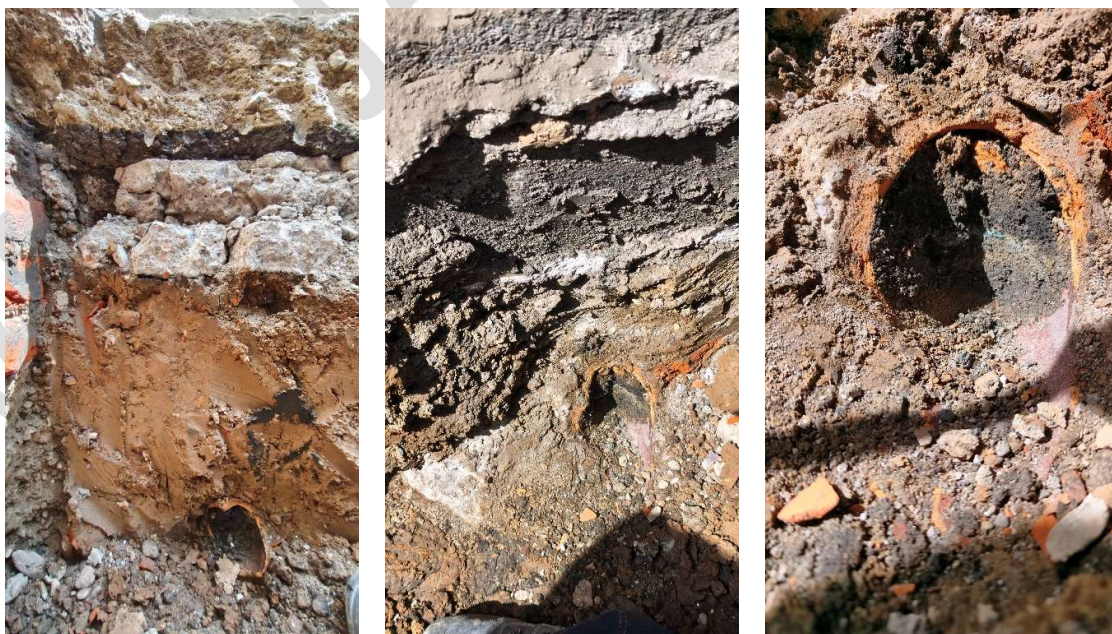
Rys. Fragment nieczynnej instalacji (prawdopodobnie kanalizacji sanitarnej) biegnącej wzdłuż ściany
