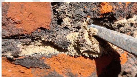
Fot. Fundament – górna część wykonana z cegły pełnej na zaprawie cementowo-wapiennej
