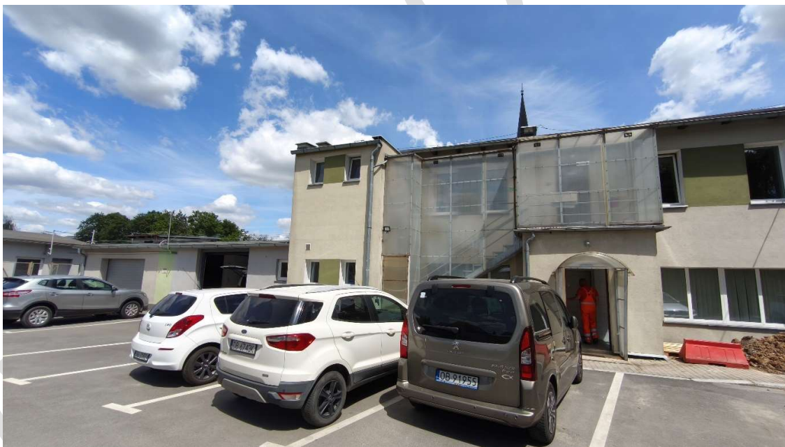
Fot. Przedmiotowy obiekt
