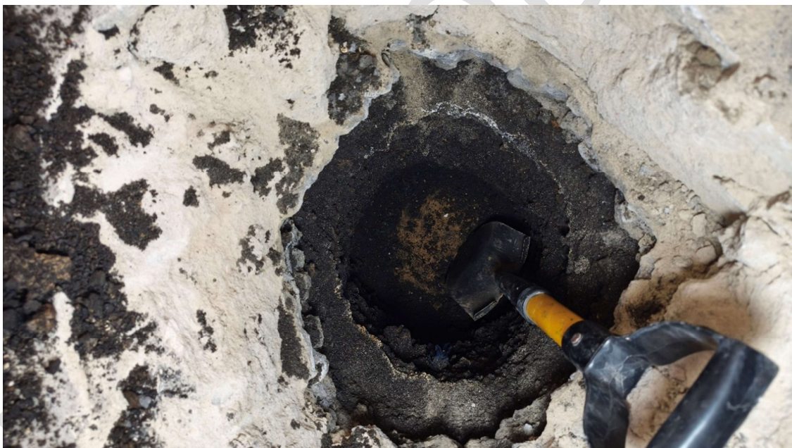
Fot. Odkrywka posadzki
