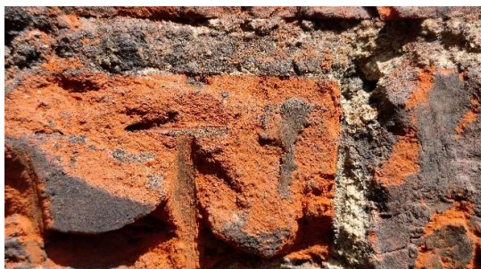
Fot. Fundament – górna część wykonana z cegły pełnej na zaprawie cementowo-wapiennej
