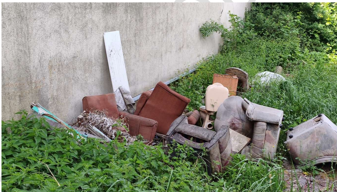
Fot. Zalegające odpady od strony wschodniej budynku. Zieleń niska utrudnia odprowadzenie wody.
