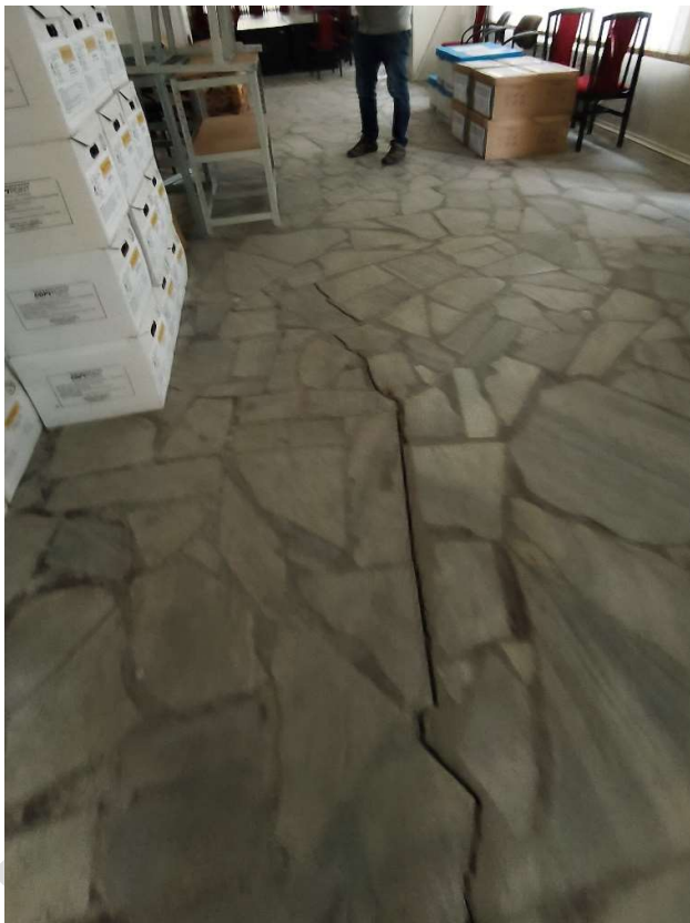
Fot. Przebieg szczeliny
