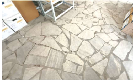
Fot. Zarysowania powstałe na posadzce budynku świetlicy – przedmiot opracowania
