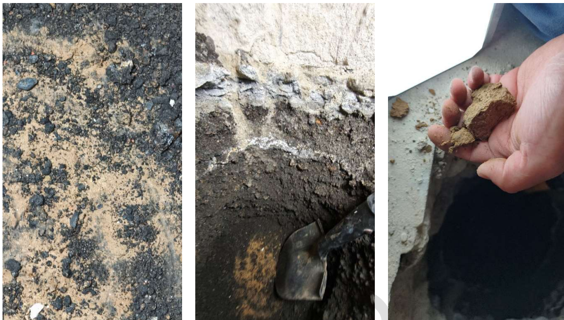
Rys. Grunt rodzimy pod warstwami podbudowy posadzki
