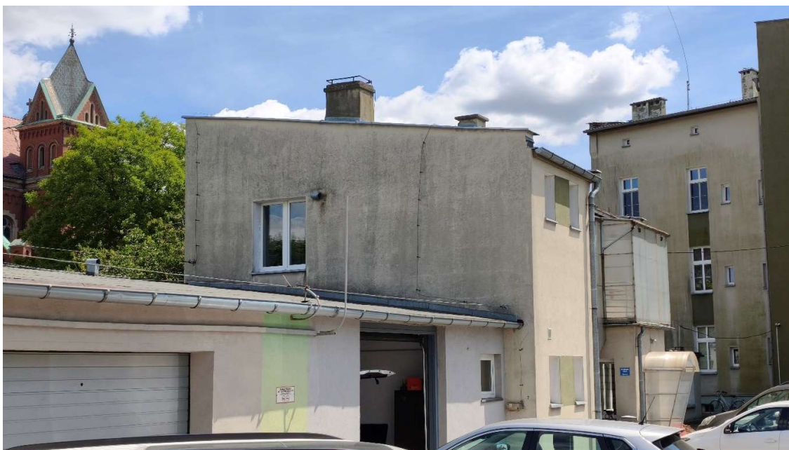
Fot. Przedmiotowy obiekt
