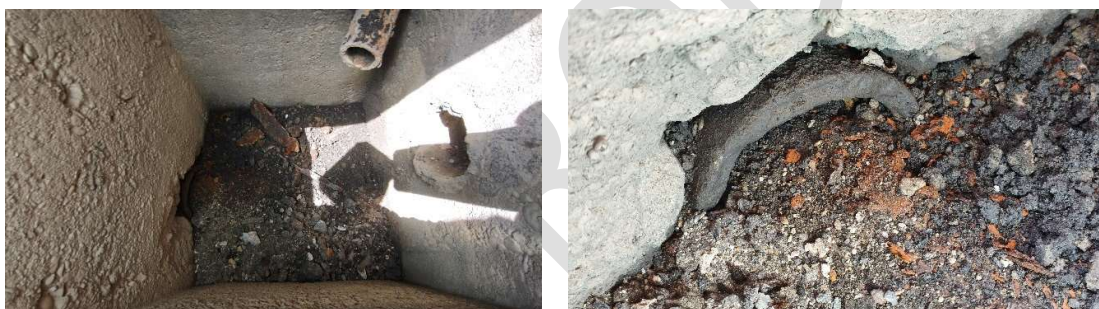
Fot. Fragment starej (nieczynnej) kanalizacji deszczowej
