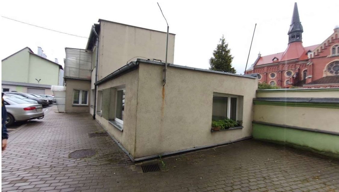
Fot. Przedmiotowy obiekt
