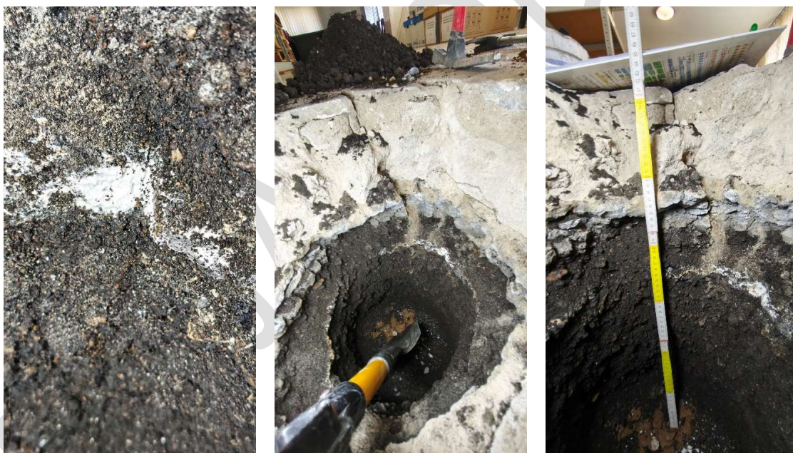
Rys. Warstwy podbudowy i posadzki z widoczną warstwą wapna
