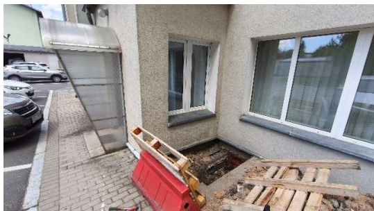
Fot. Miejsce wykonania odkrywki
