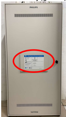
Ilustracja 1. Przednie drzwiczki głównej skrzynki rozdzielczej (gMDU).
