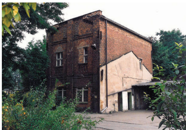
► Budynek dawnej sztygarki kopalni „Nowa Helena” w Piekarach Śląskich-Szarleju. Chodniki tej kopalni były w okresie międzywojennych chętnie wykorzystywane przez przemytników. Fot. Miejska Biblioteka Publiczna im. Teodora Heneczka w Piekarach Śląskich (zbioryspoleczne.pl)
