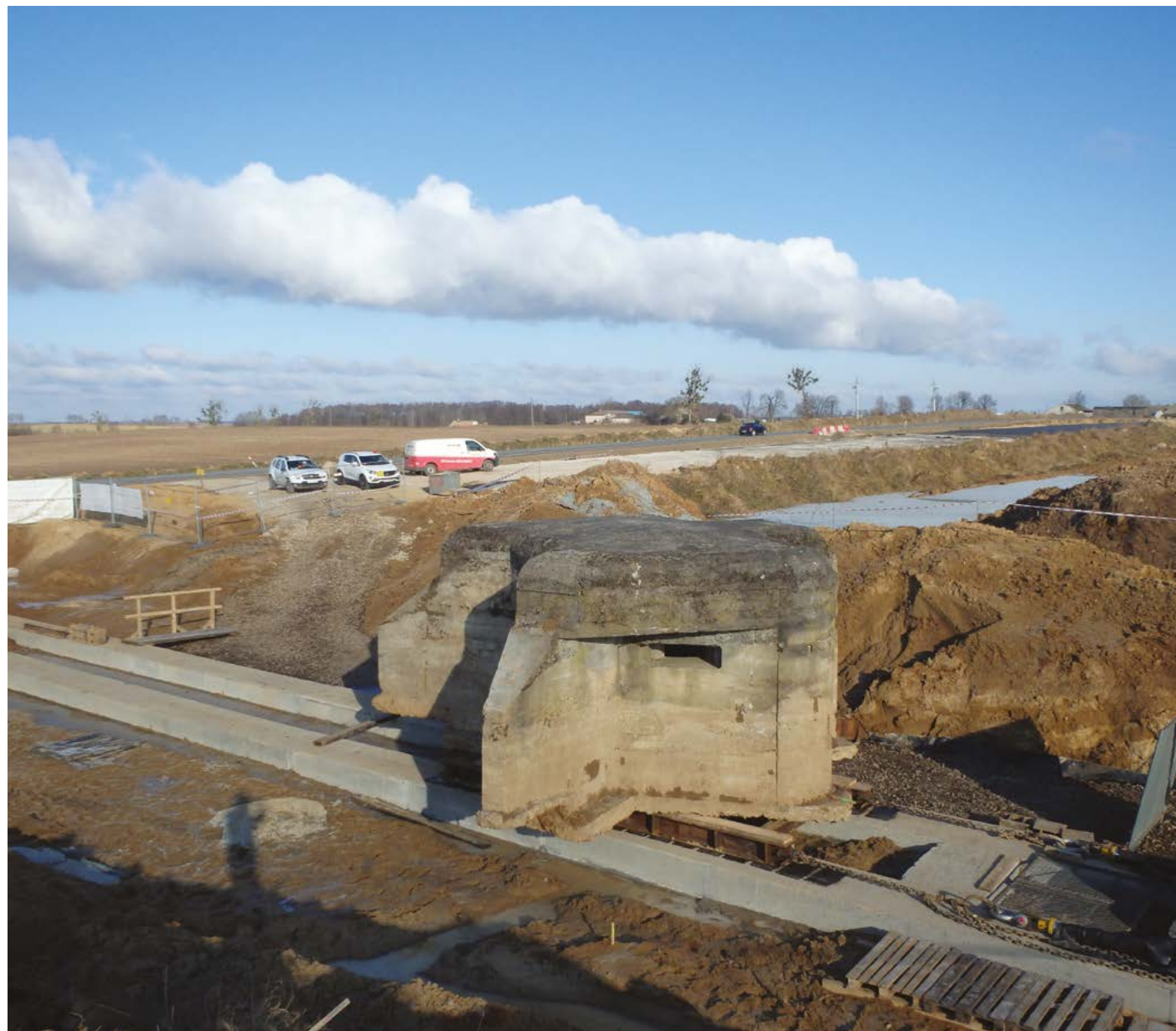
Relokacja polskiego, żelbetowego schronu z 1939 r. poza pas drogowy w pobliżu miejscowości Wąsosz. Obiekt typu 'tradaktor' o wadze ok. 145 ton został przesunięty o ok. 34 m przy pomocy specjalnych siłowników (fot. M. Wiśniewski/GDDKiA).
