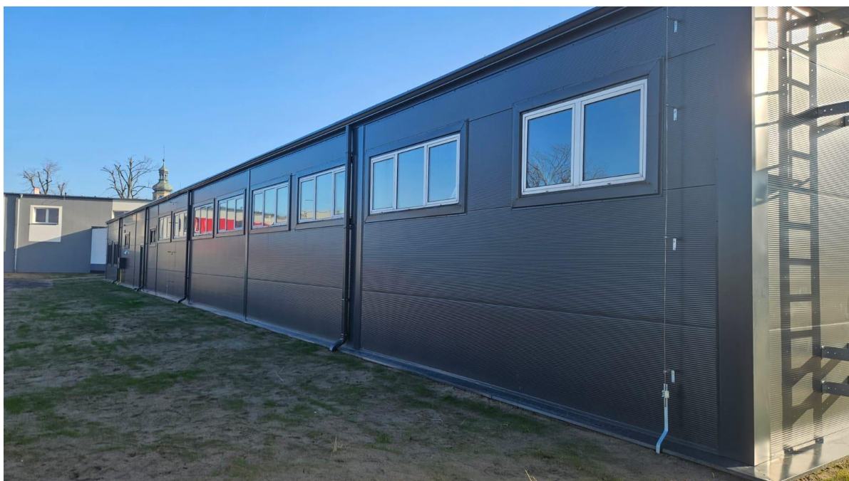
Zdjęcie nr 2 i 3. Sala gimnastyczna w Szkole Podstawowej im. Powstańców Wielkopolskich w Siedlcu, ul. Szkolna 6, 64-212 Siedlec
