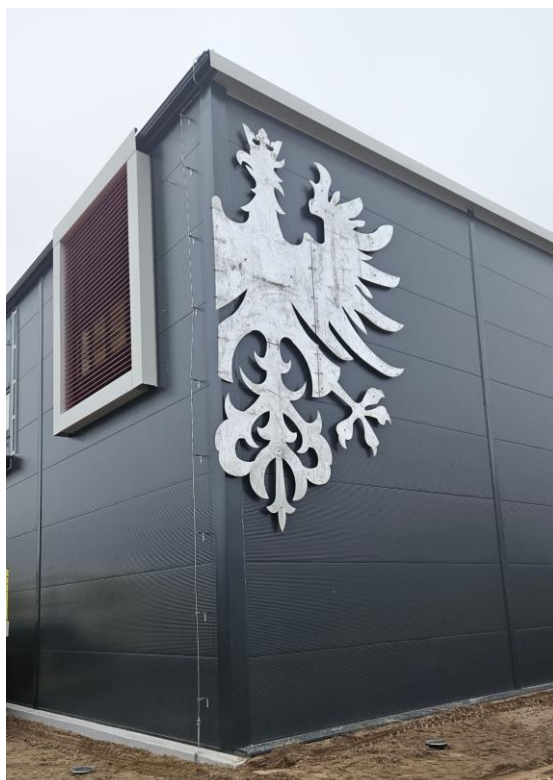
Zdjęcie nr 4. Sala gimnastyczna widok z zewnątrz w Szkole Podstawowej im. Powstańców Wielkopolskich w Siedlecu, ul. Szkolna 6, 64-212 Siedleco Ponadto w 2024 r. zmodernizowana została sala gimnastyczna oraz wyremontowane zostały pomieszczenia higieniczno-sanitarne w Zespole Szkolno-Przedszkolnym w Świętnie, ul. Szkolna 3, 64-224 Świętno.
