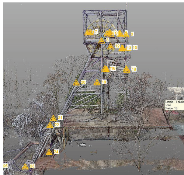
► Fot. 2. Wieża szybu Lech II – żółte trójkąty oznaczają miejsca, w których stał skaner
