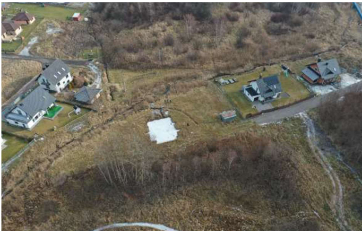
Fot. 1 Stan rozpoczętej budowy domu jednorodzinnego PAP (luty 2022).
