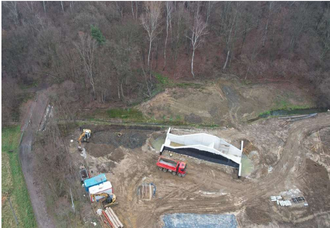
Foto. 20. Zbiornik Malinówka 2, trzecia dekada grudnia 2022 r. (urządzenie przelewowo-spustowe, czasza zbiornika)
