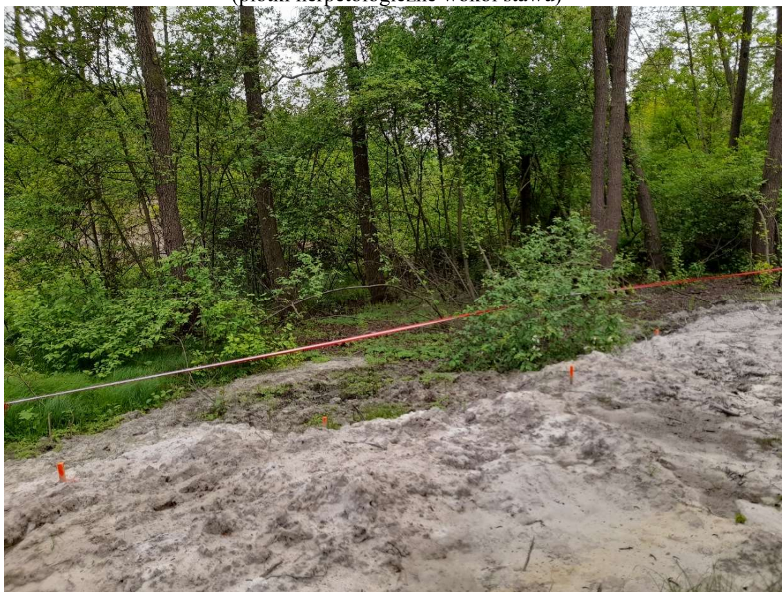
Foto. 18. Zbiornik Malinówka 2, trzecia dekada maja 2022 r. (utrzymanie wygrodzeń drzew wyłączonych z wycinki)
