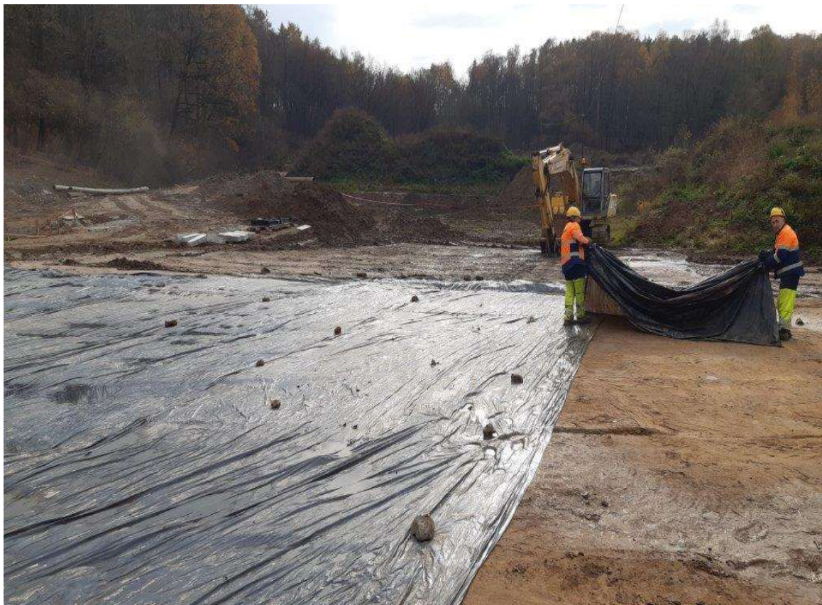
Foto. 19. Zbiornik Malinówka 2, pierwsza dekada listopada 2022 r. (prace w czaszy zbiornika)
