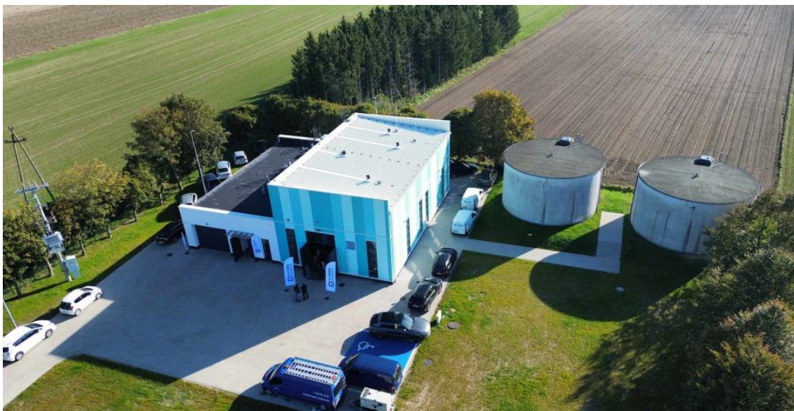
Zdjęcie 3. Nowa Stacja Uzdatniania Wody w Bukownicy
