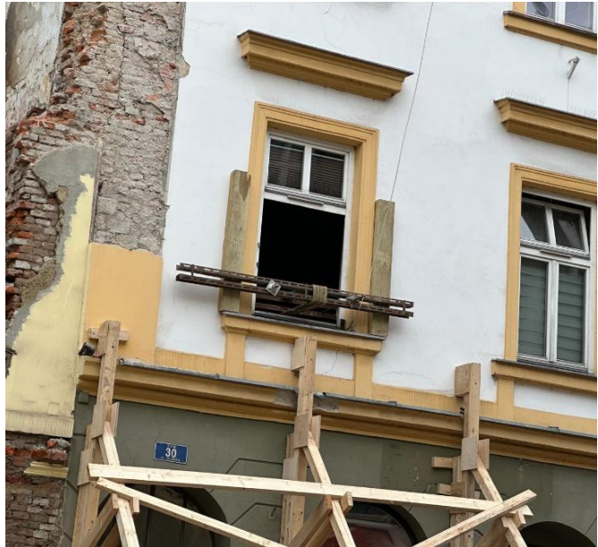
Fot. 1, 2. Zabezpieczenie po katastrofie budowlanej w Cieszynie 2024 roku (autor: mł. ogn. Kamil Nadolski)
