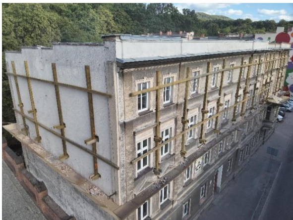
Fot. 3, 4. Zabezpieczenie uszkodzonego budynku (autor: bryg. Maciej Garczyński)
