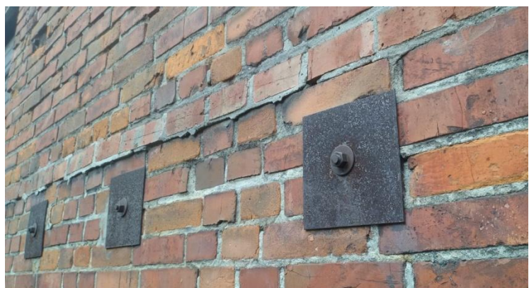
Fot. 5, 6, 7. Zabezpieczenie budynku na terenie objętym oddziaływaniem szkód górniczych (autor: mł. bryg. Mirosław Goraus)
