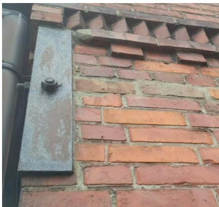
Fot. 5, 6, 7. Zabezpieczenie budynku na terenie objętym oddziaływaniem szkód górniczych (autor: mł. bryg. Mirosław Goraus)
