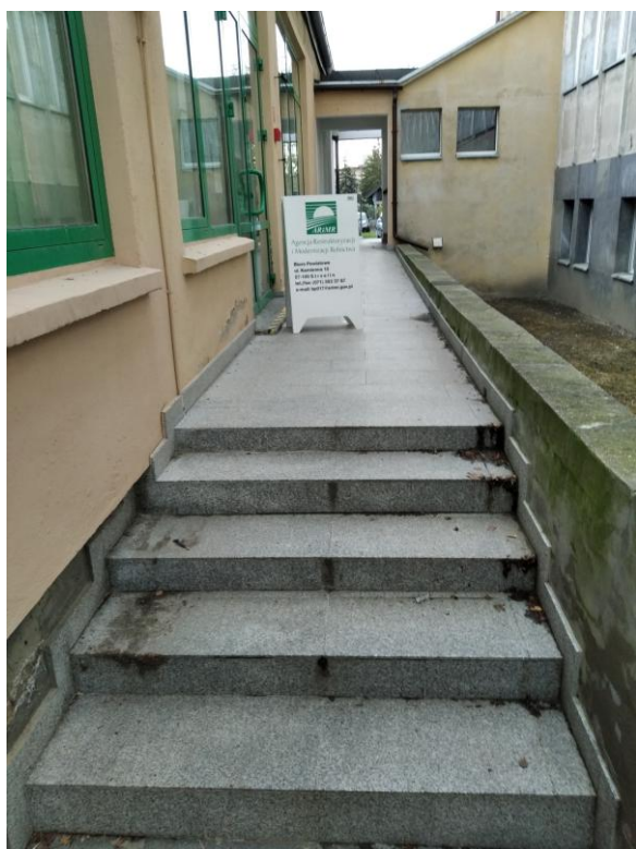
Zdjęcie nr 2 – wejście od strony południowej
