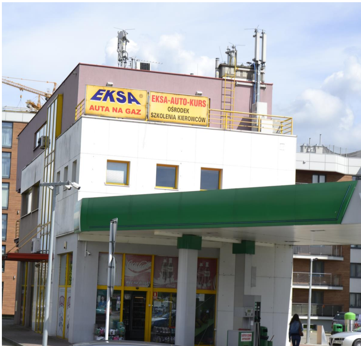
Fot. 1: Widok anten stacji bazowej ID: RZE1012D, zlokalizowanej przy ul. Powstańców Warszawy 16 w Rzeszowie
