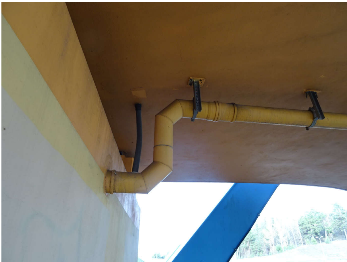
Fot. 4. Widok na przejście kolektora przez przyczółek od strony m. Dobrzyniewo.
