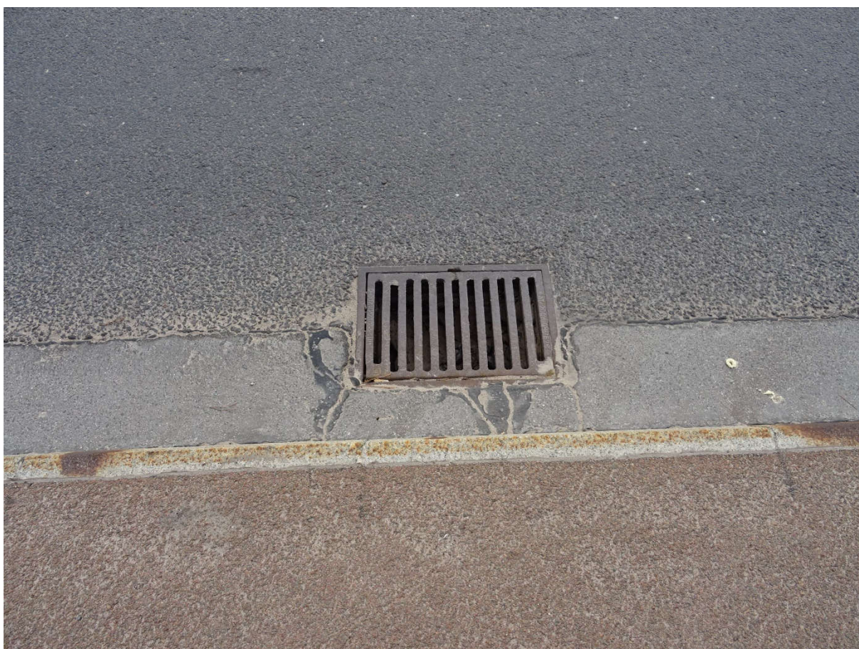
Fot. 5. Wpust na wiadukcie.
