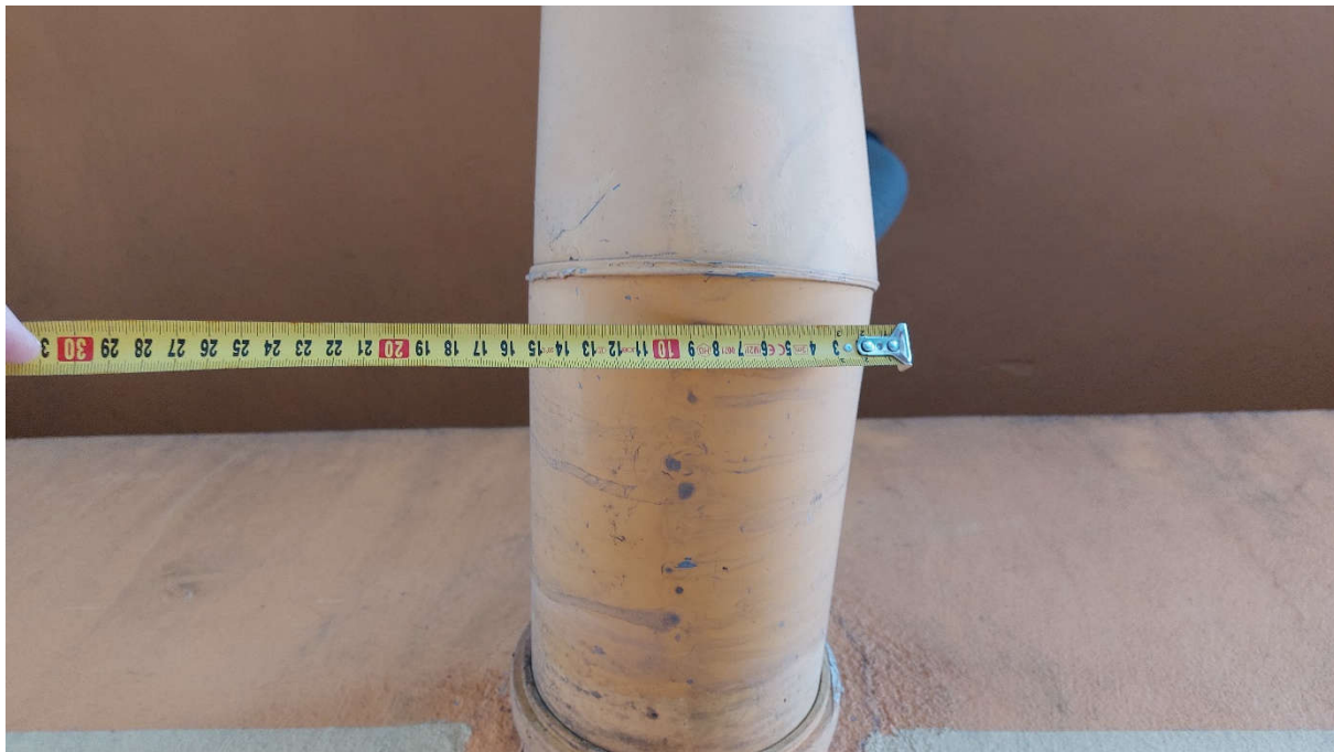
Fot. 2. Pomiar istniejącego kolektora.
