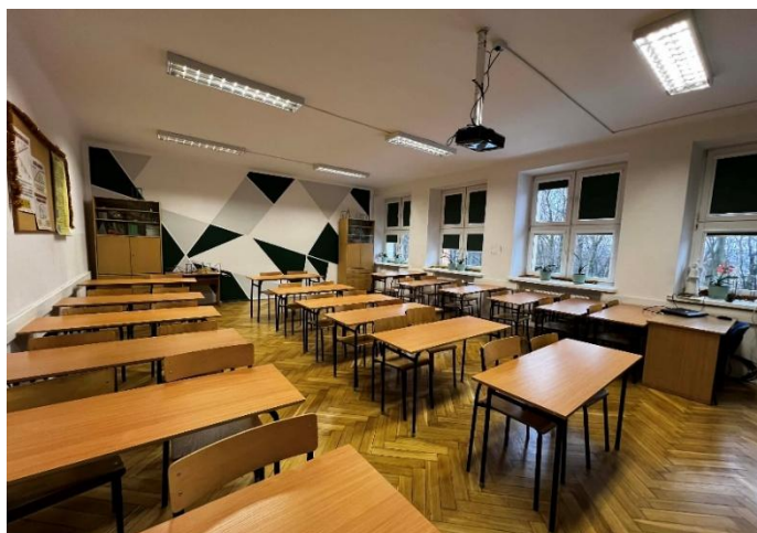
Zdjęcie 5. Placówki oświatowe po przeprowadzonych w okresie wakacyjnym pracach remontowych.
