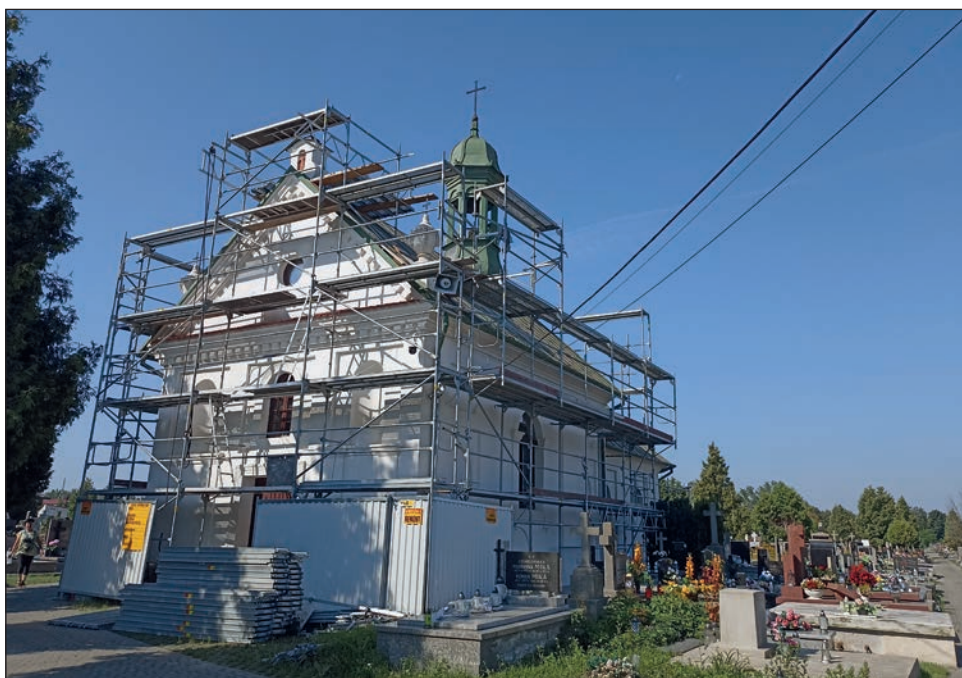
2. Kaplica w trakcie prac przy fasadzie, fot. B. Stolarz, 2022
