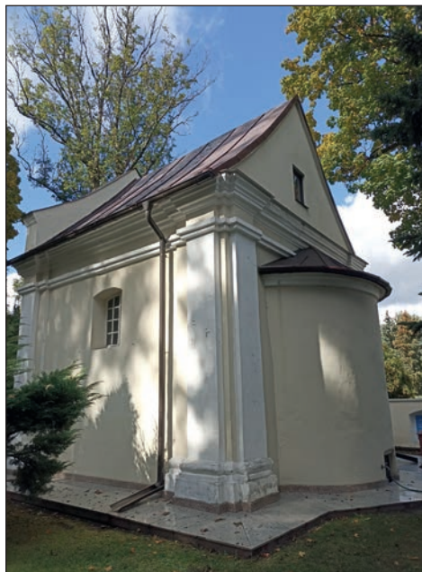
14. Kaplica Zjawienia przed pracami, fot. B. Stolarz, 2022
