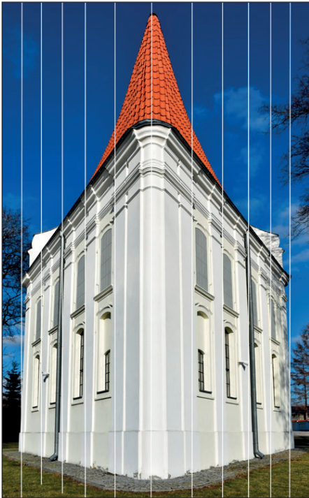
11. Widok kaplicy od strony południowo-zachodniej – wizualizacja złudzenia optycznego równego rozstawu pilastrów, oprac. H. Mącik.
