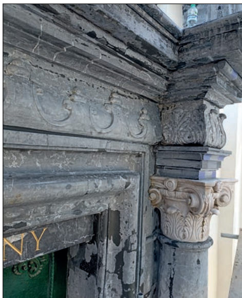
14. Fragment portalu wejścia głównego, stan przed pracami, fot. M. Filip
