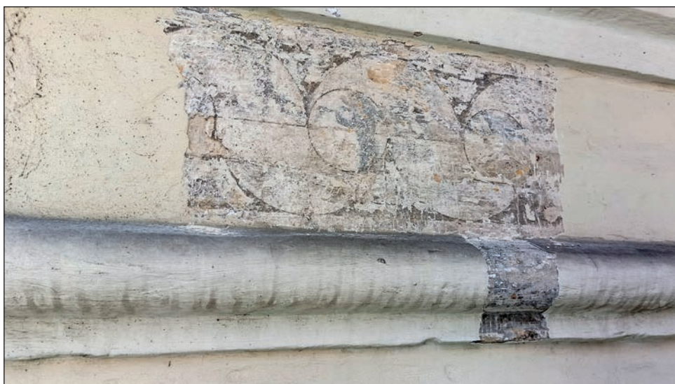
25. Odślonięty w trakcie prac fryz dzwonnicy, fot. B. Stolarz, 2024
