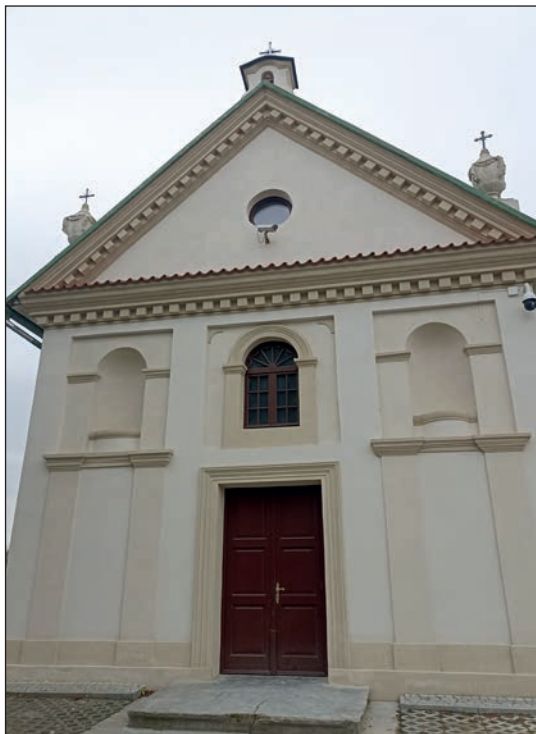
5. Fasada kaplicy po pracach, fot. B. Stolarz, 2022
