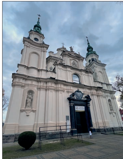
19. Fasada kościoła, po pracach, fot. ks. A. Jużko
