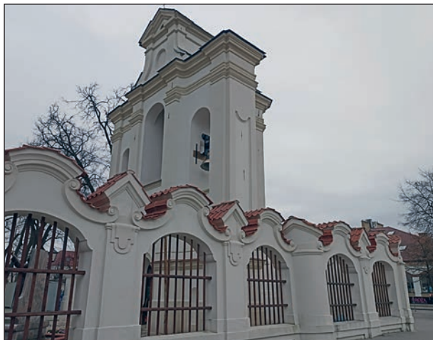
23. Dzwonnica i fragm. ogrodzenia, po pracach, fot. B. Stolarz
