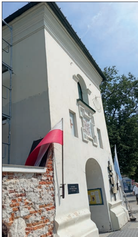
21. Dzwonnica przed pracami, fot. B. Stolarz, 2024
