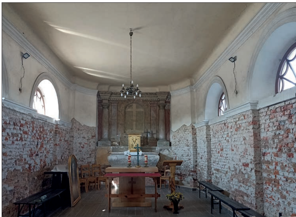
12. Wnętrze prezbiterium po skuciu zawilgoconych tynków, fot. B. Stolarz, 2022
