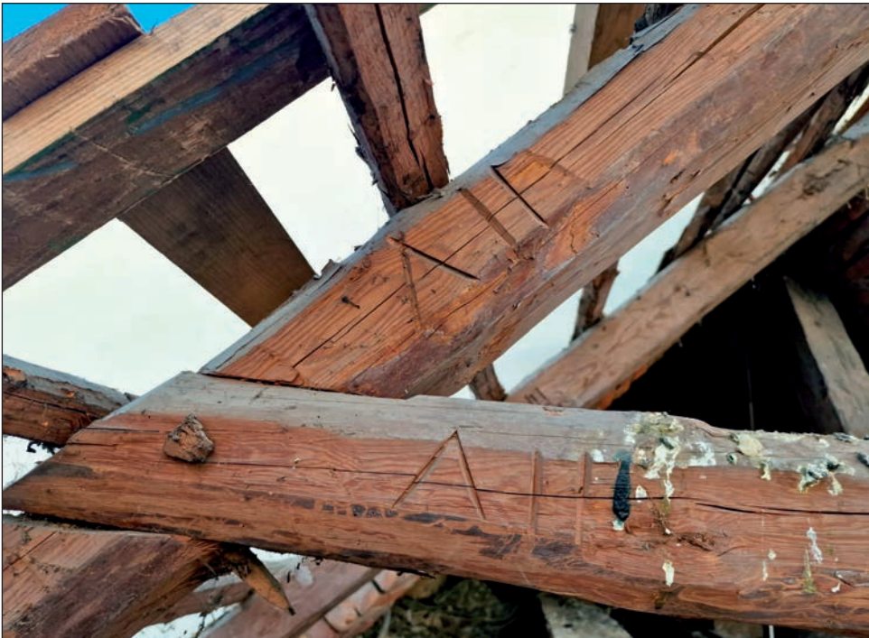
8. Fragment więźby dachowej nad prezbiterium kaplicy, fot. B. Stolarz, 2022
