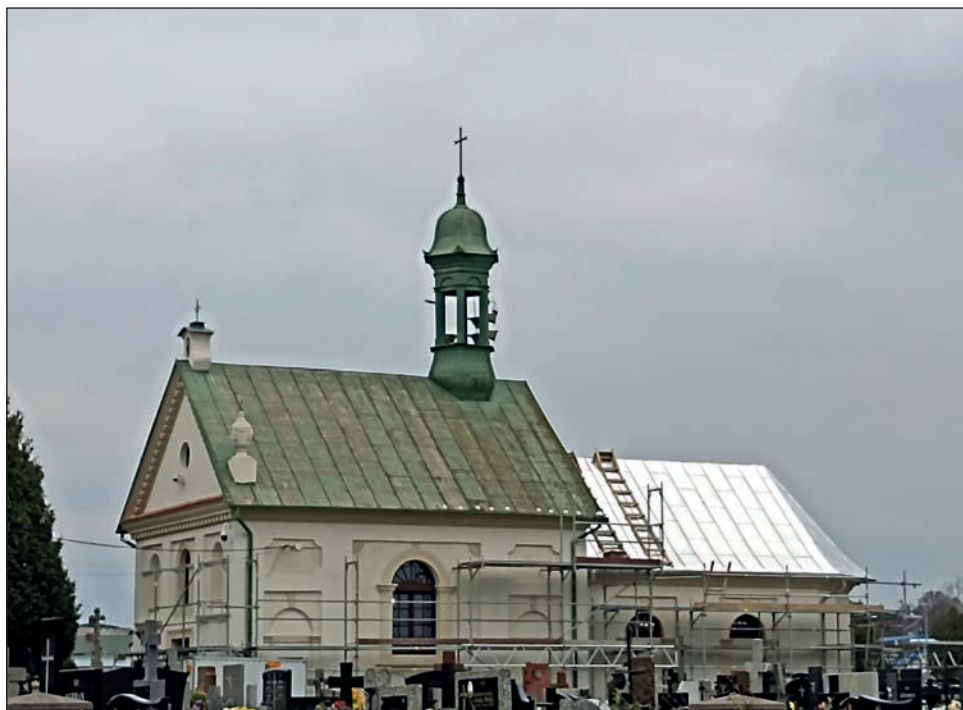
10. Prezbiterium kaplicy po wykonaniu pokrycia dachowego, fot. B. Stolarz, 2022
