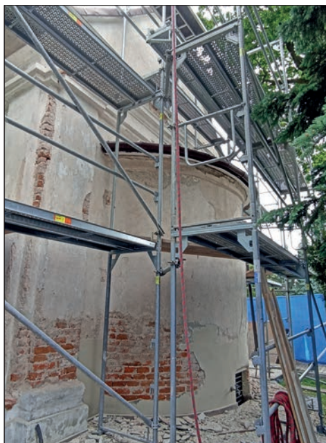
17. Kaplica Zjawienia w trakcie prac, fot. B. Stolarz, 2023
