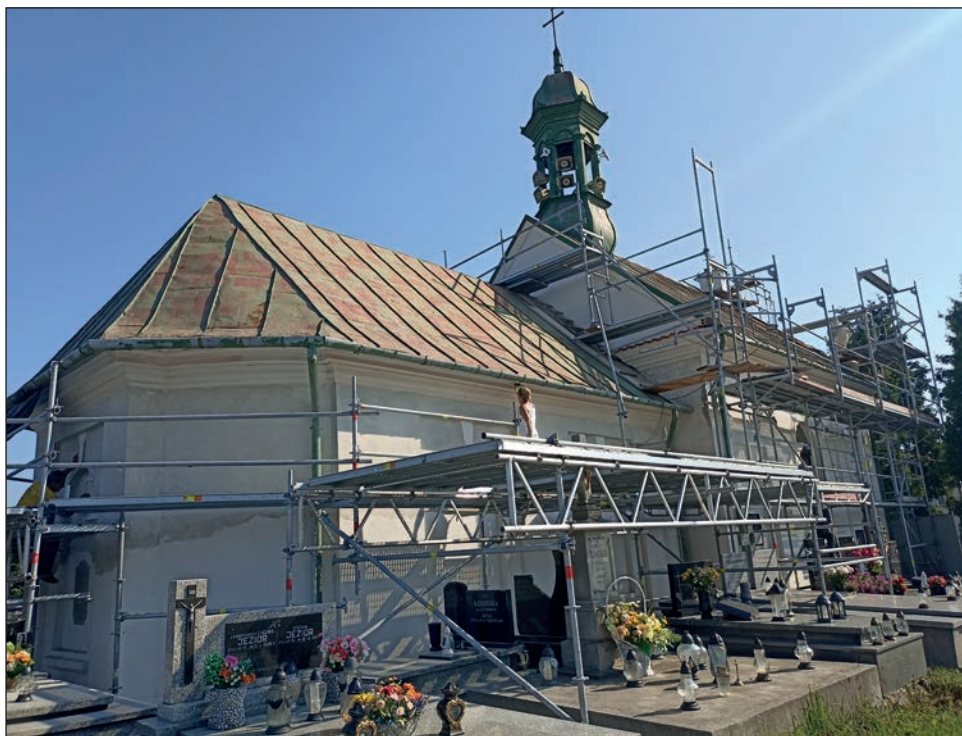
3. Kaplica w trakcie prac przy elewacji bocznej, fot. B. Stolarz, 2022
