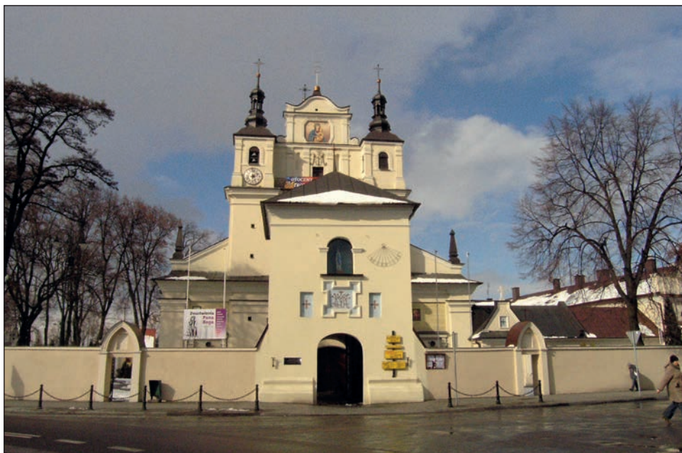
1. Widok na zespół kościelny przed pracami, fot. K. Tur-Marciszuk, 2009
