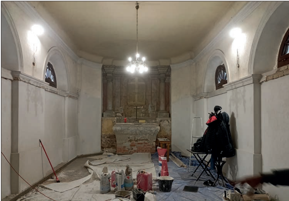
16. Wnętrze kaplicy po uzupełnieniu tynków, fot. B. Stolarz, 2023
