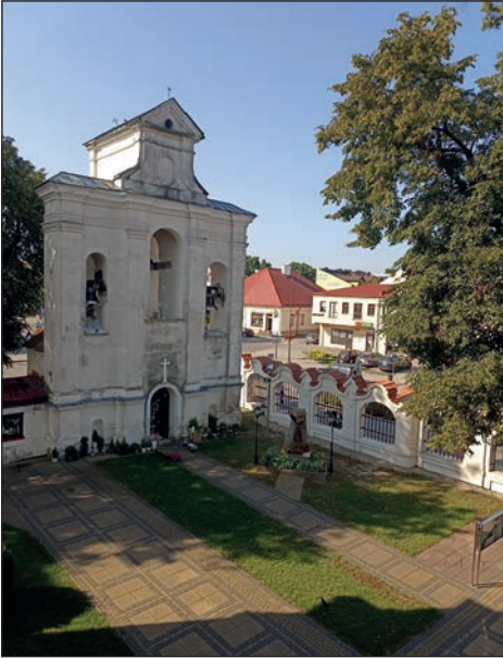
20. Dzwonnica, przed pracami, fot. B. Stolarz
