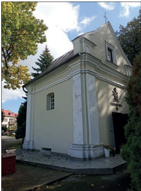
13. Kaplica Zjawienia przed pracami, fot. B. Stolarz, 2022
