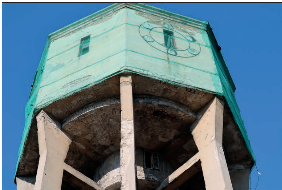
8. Lotniskowa wieża ciśień – fragm. konstrukcji, fot. A. Stawinoga, 2023
