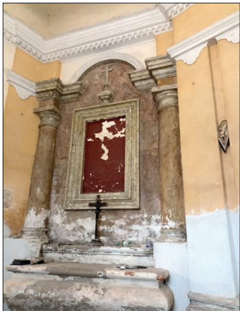
17. Ołtarz boczny po uzupełnieniu tynków, fot. B. Stolarz, 2023
