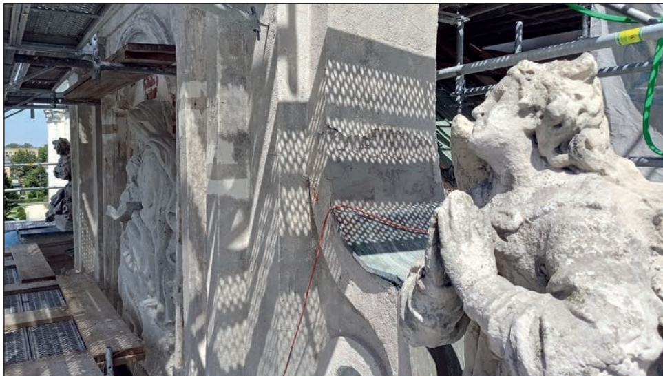
6. Elementy dekoracji fasady, w trakcie prac, fot. M. Filip
