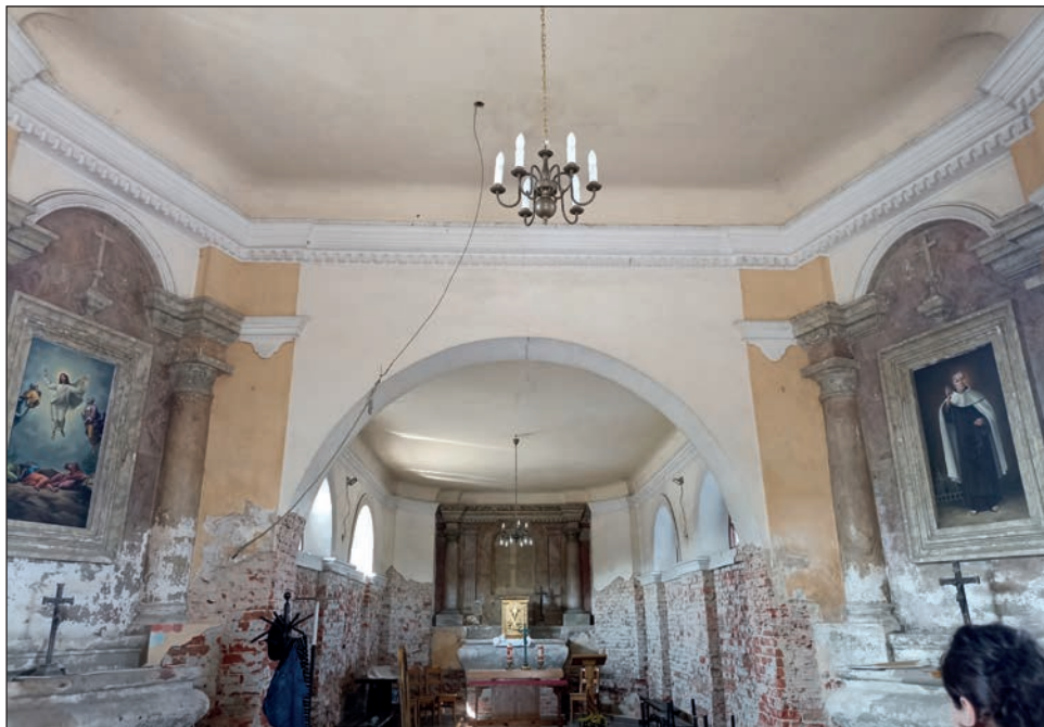
11. Wnętrze kaplicy po skuciu zawilgoconych tynków, fot. B. Stolarz, 2022
