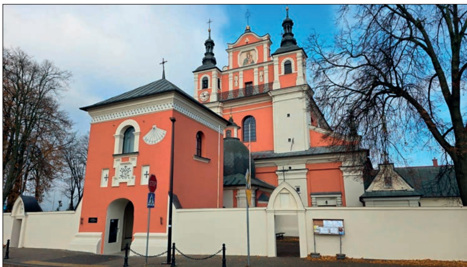
30. Mur ogrodzeniowy z dzwonnica po pracach, fot. B. Stolarz, 2024
