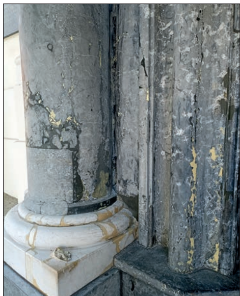
15. Fragment portalu wejścia głównego, stan przed pracami, fot. M. Filip
