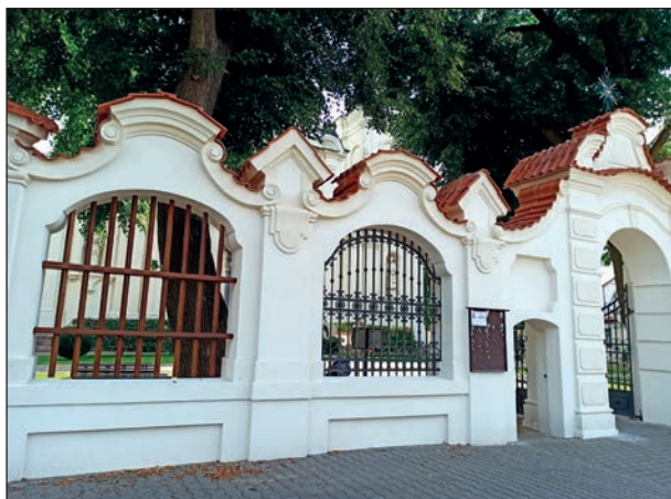
24. Ogrodzenie po pracach, fot. B. Stolarz
