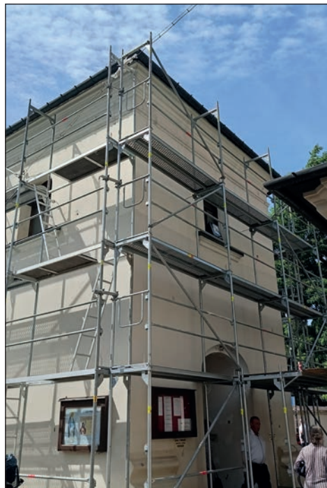
24. Dzwonnica w trakcie prac, fot. B. Stolarz, 2024
