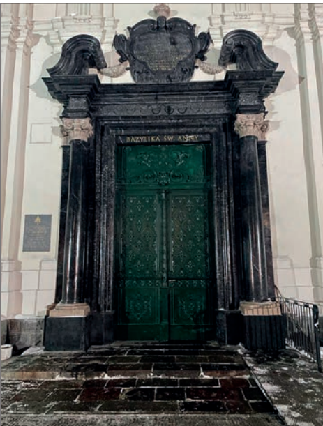
18. Portal wejścia głównego, po pracach, fot. M. Filip
