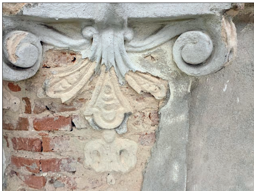
2. Detal elewacji, stan przed pracami, fot. M. Filip
