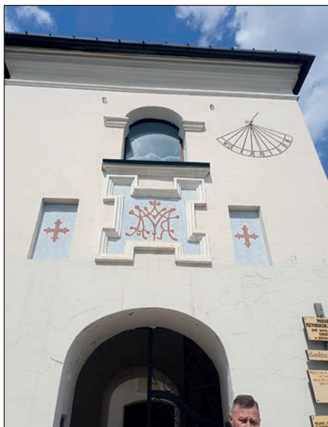
22. Dzwonnica przed pracami, fot. B. Stolarz, 2024
