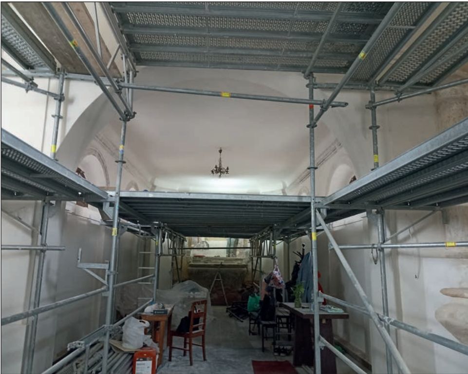
21. Wnętrze kaplicy w trakcie prac przy sklepieniu, fot. B. Stolarz, 2024
