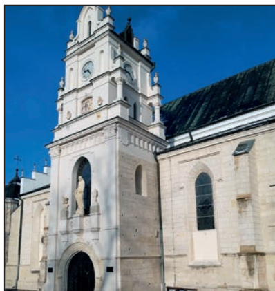
9. Widok kruchty po pracach, fot. M. Filip, 2024
