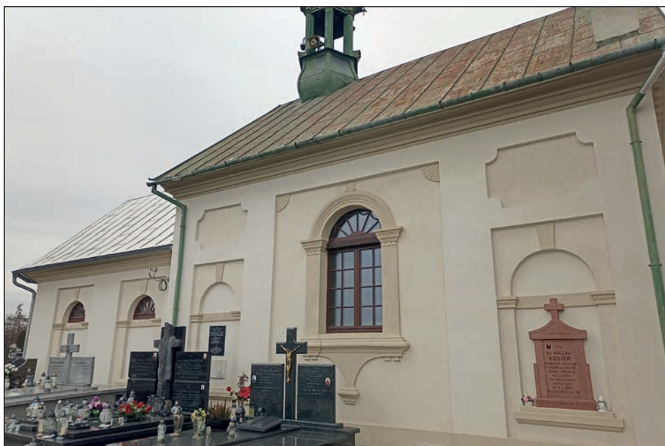
6. Elewacja boczna kaplicy po pracach, fot. B. Stolarz, 2022
