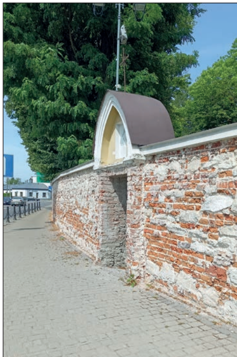
27. Mur ogrodzeniowy w trakcie prac, fot. B. Stolarz, 2024
