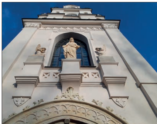
10. Widok frontalny kruchty po pracach, fot. M. Filip, 2024
