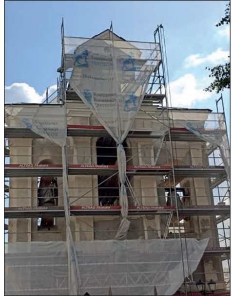
21. Dzwonnica w trakcie prac, fot. B. Stolarz
