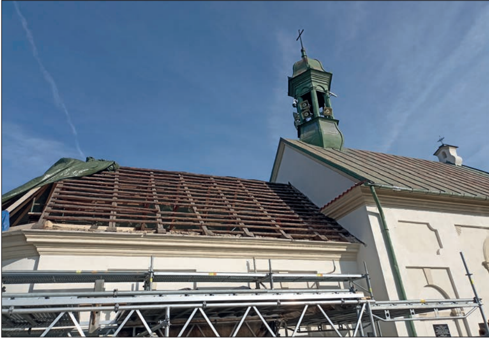
7. Prezbiterium kaplicy po demontażu pokrycia dachowego, fot. B S tolarz, 2022
