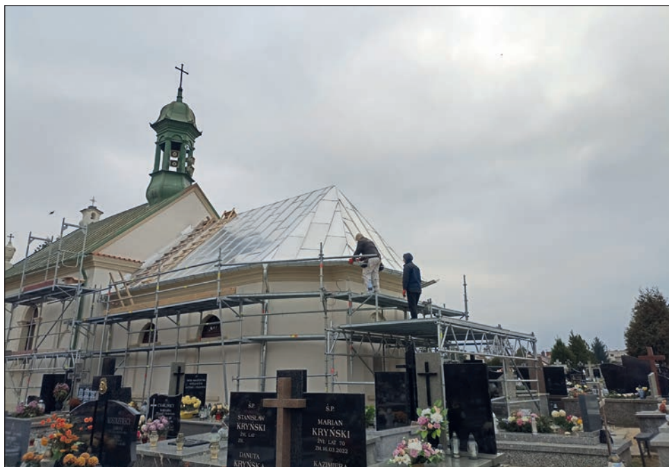
9. Prezbiterium kaplicy po wykonaniu pokrycia dachowego, fot. B. Stolarz, 2022
