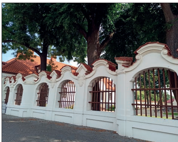
25. Ogrodzenie po pracach, fot. B. Stolarz
