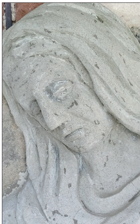
5. Fragment płaskorzeźby na fasadzie, stan przed pracami, fot. M. Filip
