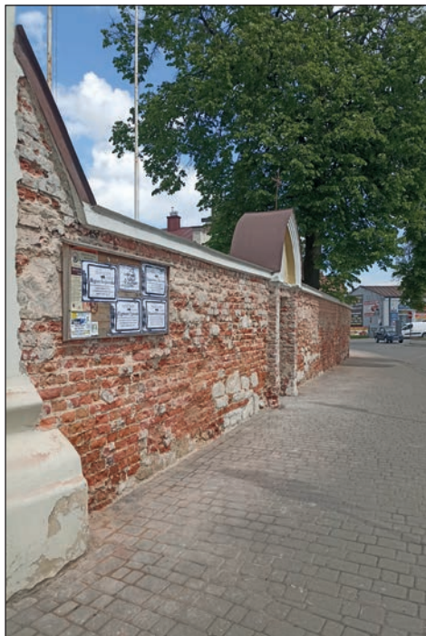
26. Mur ogrodzeniowy w trakcie prac, fot. B. Stolarz, 2024
