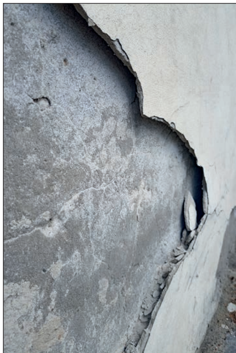
23. Mur ogrodzeniowy przed pracami, fot. B. Stolarz, 2024
