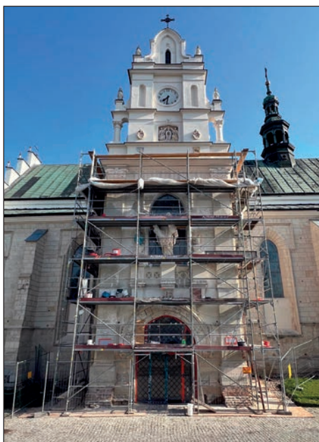
6. Widok frontalny na kruchtę w trakcie prac, fot. B. Stolarz, 2024
