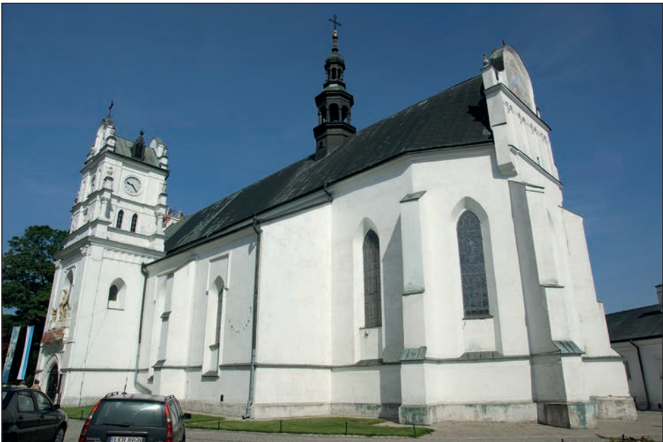
4. Widok kościoła przed remontem, fot. B. Stolarz, 2008
