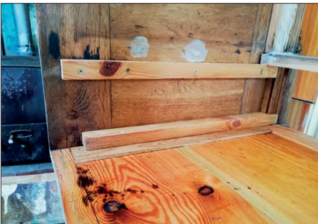
6. Przeznaczona do wymiany wytarta prowadnica szuflady, fot. P. Hapka
