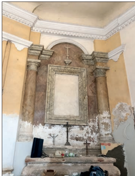
18. Ołtarz boczny po uzupełnieniu tynków, fot. B. Stolarz, 2023
