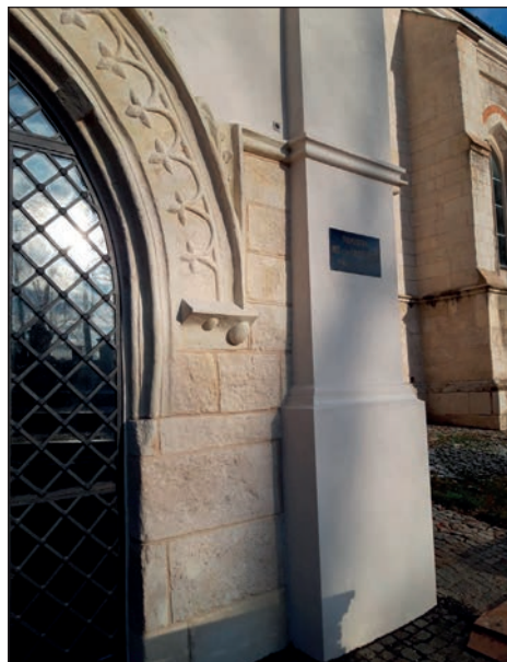
12. Widok części cokołowej kruchty po pracach, fot. M. Filip, 2024
