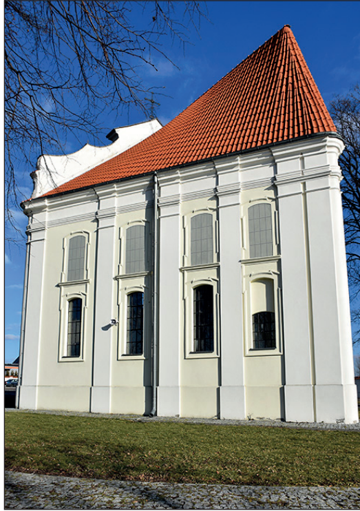
10. Elewacja zachodnia kaplicy w Stróży – widoczne nierówne rozstawienie pilastrów, fot. H. Mącik, 2022.
