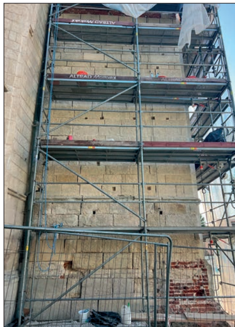
7. Widok od strony zachodniej kruchty w trakcie prac, fot. B. Stolarz, 2024
