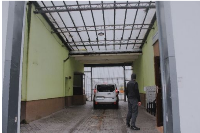
Fotografia nr 5 Śluzka bramy wjazdowej AŚ Warszawa-Białoleka
