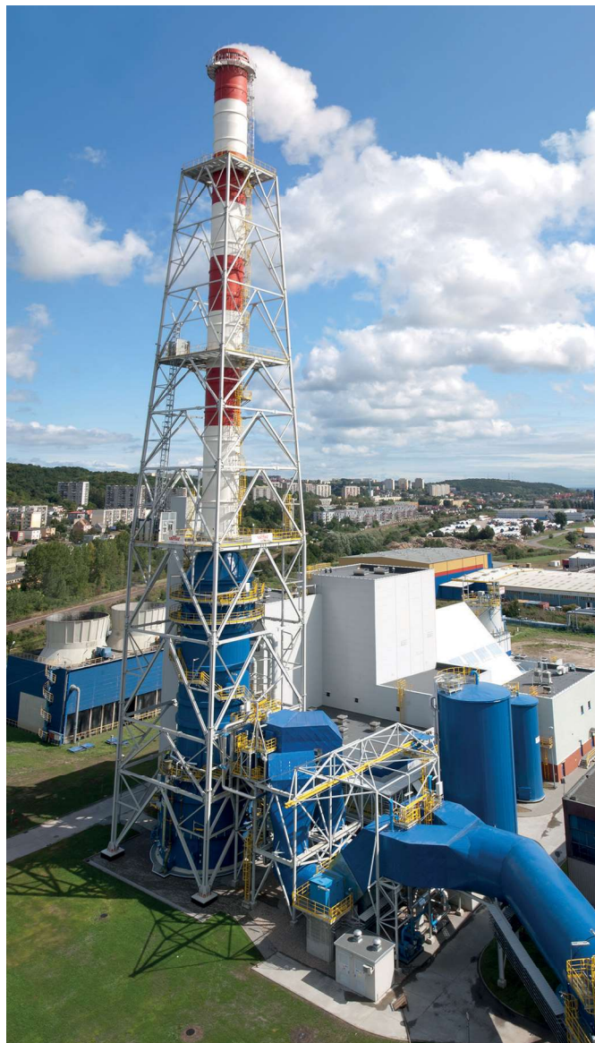
Instalacja odsiarczania spalin (IMOS) w EC Gdyńskiej
