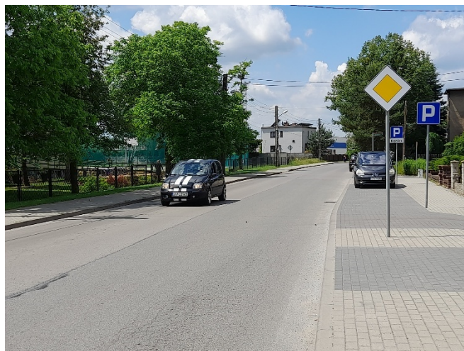
Fot. 12. Miasteczko Śląskie, RB4. Badany odcinek ul. Dworcowej w kierunku skrzyżowania z ul. Sztolnią.
