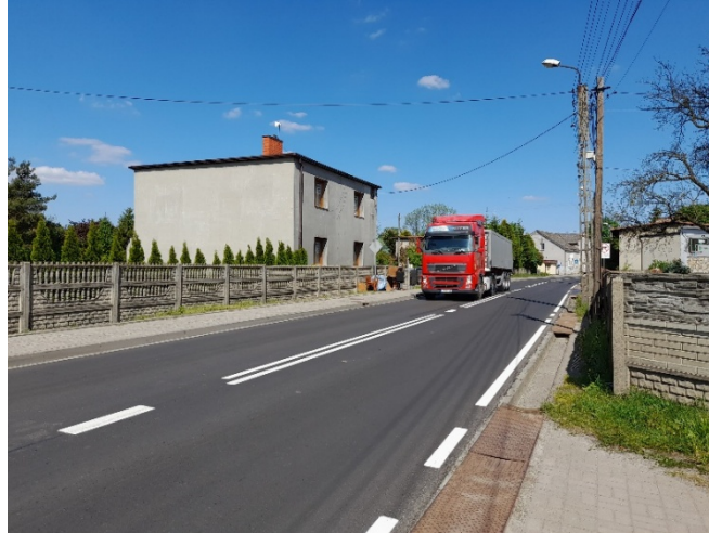
Fot. 3. Żyglin, gm. Miasteczko Śląskie, RB1. Badany odcinek ul. Śląskiej w kierunku skrzyżowania z ul. Woźnicką DW 908.
