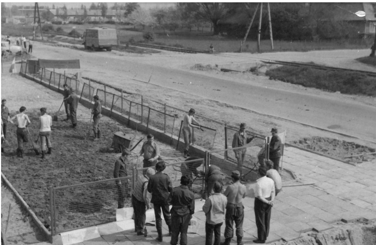
Rys. 15. Fotografia przedstawiająca prace przy budowie nowej siedziby Straży Pożarnych Źródło: zbiory prywatne Piotra Słowiaka
