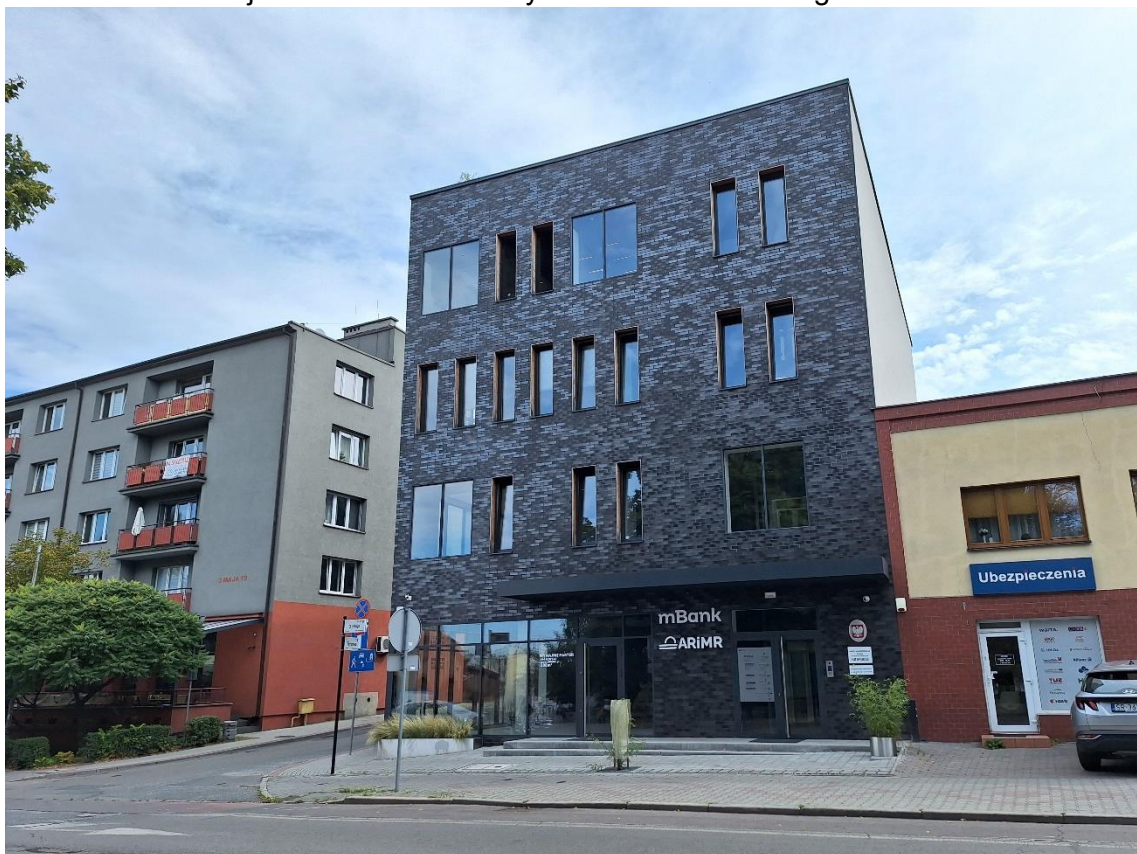
Wejście frontowe do budynku Biura Powiatowego ARiMR
