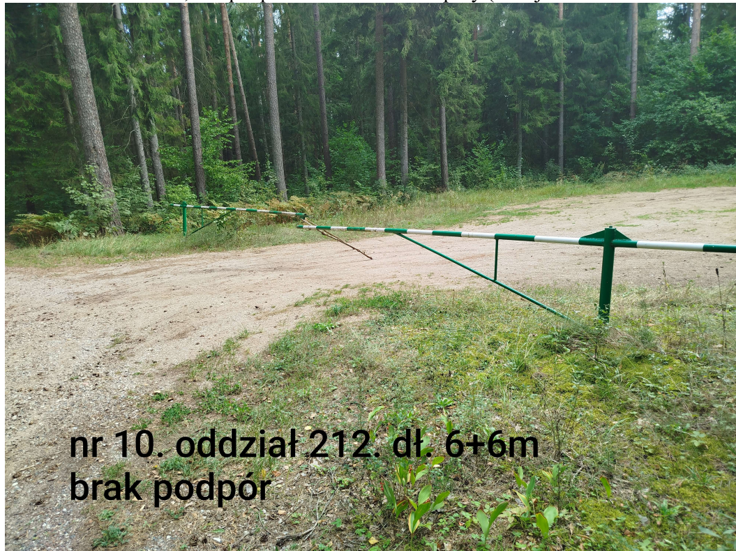
10. Leśnictwo Walne, bez podpór do odstawienia zapory (mniejsza średnica ramienia zapory)
