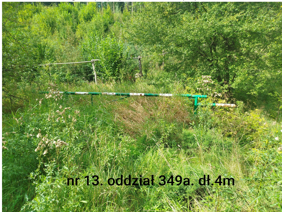
14. Leśnictwo Białorogi, bez podpory do odstawienia zapory
