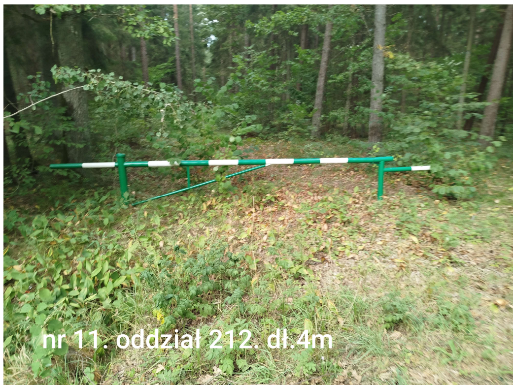
12. Leśnictwo Białorogi, bez podpory do odstawienia zapory
