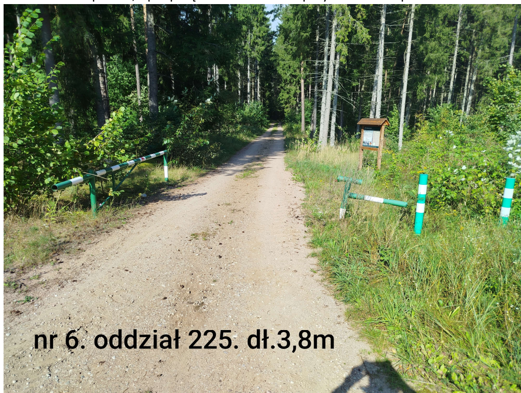
6. Leśnictwo Papiernia, z podporą do odstawienia zapory i dwoma słupkami U-2
