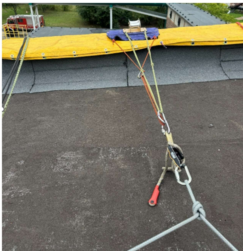
Fot. 15. Zabezpieczenie rolki krawędziowej oraz maty przed zsunięciem się na dół
