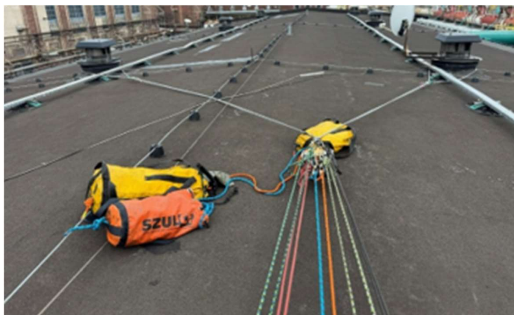
Fot. 12. Stanowisko ratownicze zbudowane z dwóch kominów, zakończone płytką stanowiskową
