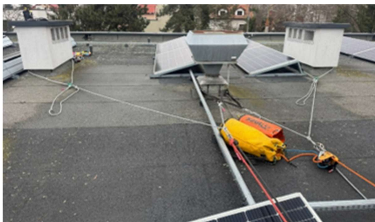
Fot. 13. Stanowiska ratownicze zbudowane z kilku punktów
