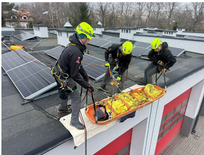
Fot. 27. Przełożenie noszy na dach, podczas wyciągania
