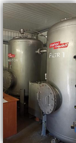
Zdjęcie 1) Filtry odżelaziająco-odmanganiające
