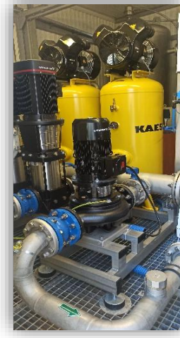
Zdjęcie 2) Sprężarki i zestaw pomp II stopnia
