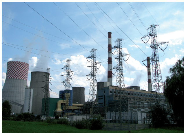
Fot. 1. Stacja wysokiego napięcia przy Elektrowni Łagisza w Będzinie
