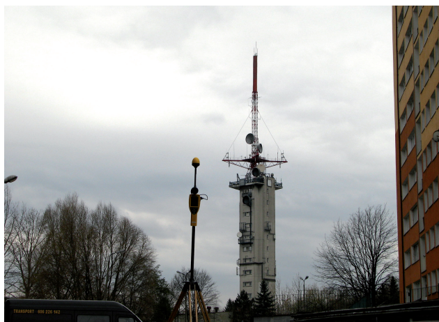
Fot. 6. Stacja linii radiowych Bytków w sąsiedztwie punktu pomiarowego w Siemianowicach Śląskich, przy ul. Wróblewskiego
