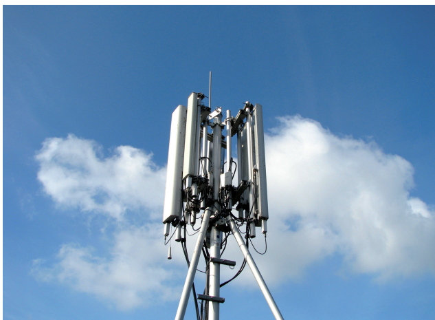
Fot. 3. Anteny sektorowe stacji bazowej telefonii komórkowej
