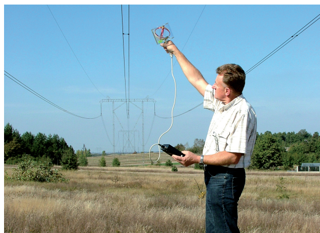
Fot. 7. Trójosiowy miernik indukcji magnetycznej TRACER 3D usytuowany pod siecią elektroenergetyczną
