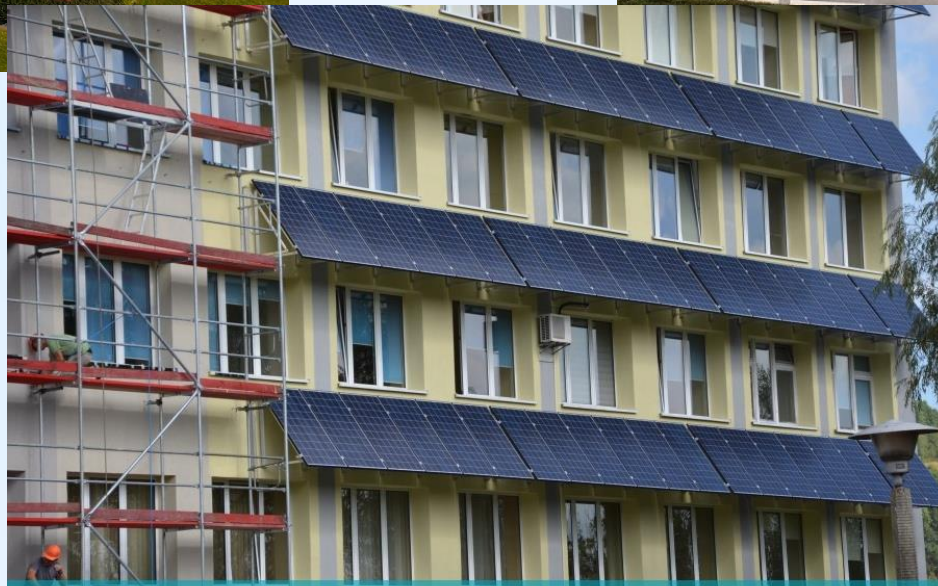
Prace związane z instalacją modułów fotowoltaicznych - 16.09. 2015 r.
