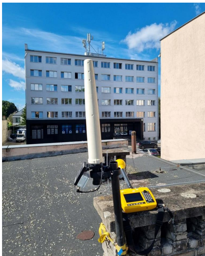
Rys. 2. Miejsce montażu SMS PEM – Internat ZSE w Pile – widok na SBTK
