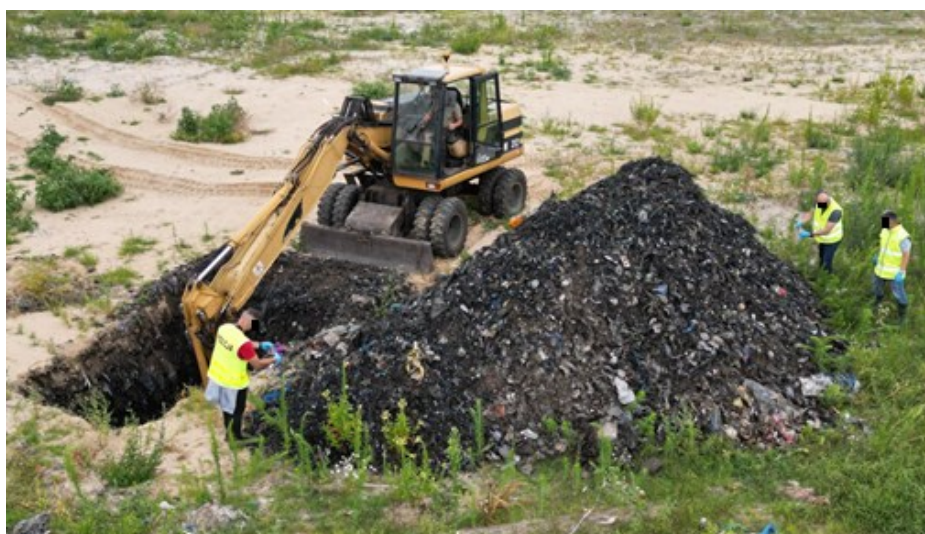
Zdjęcie 27. Dokumentacja czynności realizowanych w miejscu ujawnienia zakopanych odpadów
