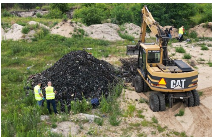
Zdjęcie 26. Dokumentacja czynności realizowanych w miejscu ujawnienia zakopanych odpadów
