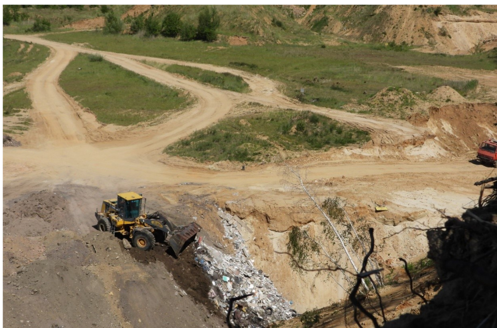
Zdjęcie 22. Wypełnianie wyrobiska odpadami
