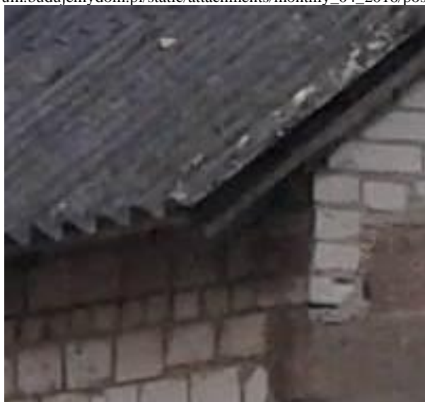
zdjęcie detalu ukazujące część eternitu na dachu
