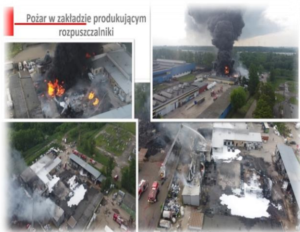
Zdjęcie IV.2. Pożar zakładu
