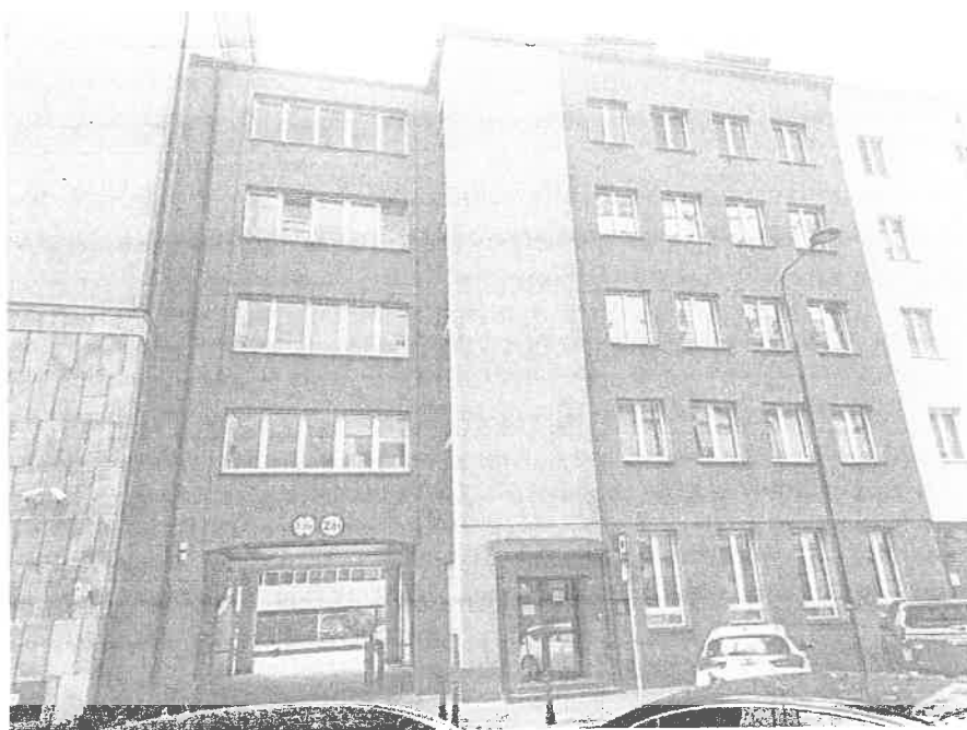
Fot. 2. Widok ogólny budynku „B” stanowiącego przedmiot opracowania. Na pierwszym planie widoczna klatka schodowa.
