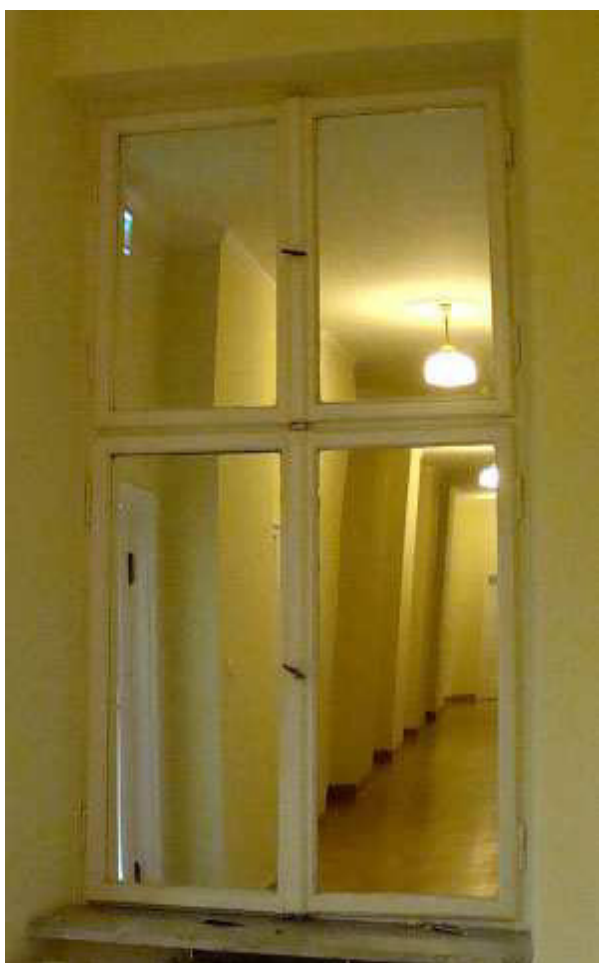
◀ Poziom I p.-korytarzu skrzydła ptn.-wsch. Okno nr 361. Szyby skrzydeł wewnętrznych - lustro. pow. okna 3,03m 2 . 3 okna analogiczne (bez luster) w pom. nr:100;100A. Remont z pełną konserwacją
