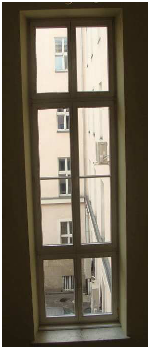
▲ Poziom II p., okno nr 252 na bocznej klatce schodowej, Okno drewniane, jednoramowe z dwoma ślemionami, Szkłone pakietem termicznym. Powierzchnia 4,95m^2 . W budynku jest 1 sztuka okna tego typu.
