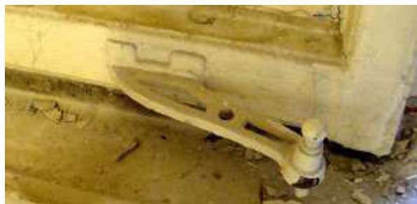
▲ ▼ Przykłady zachowanych mosiężnych okuć, do konserwacji
