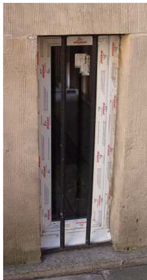
Okno pomieszczenia technicznego nr ► jednoramowe z pakietem termicznym, wykonane z PCV, widok od strony dziedzińca
