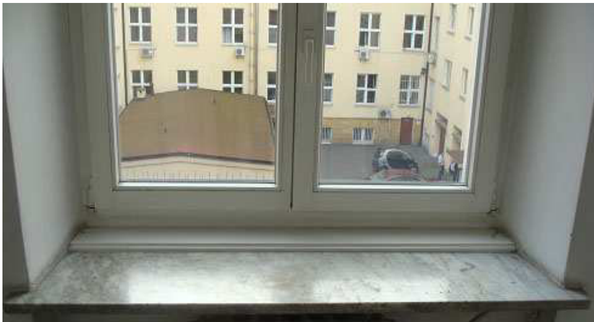
▲ Okno jednoramowe – II piętro wykonać remont 120 s okien, Powierzchnia 1 okna 2,4m 2
