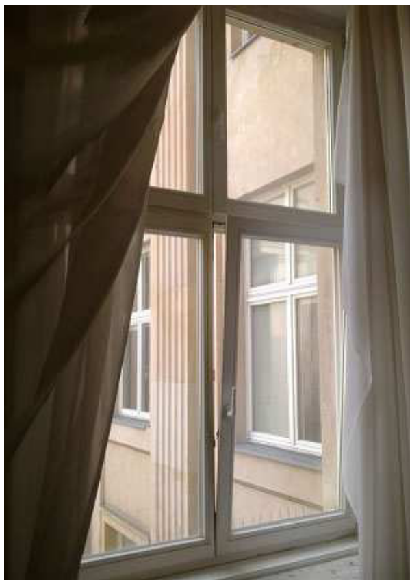
▲ Okna z jednym ślemieniem, I p., s nr 103, pow. 2,94m^2 ▼ II piętro, pokój biurowy nr 277, pow. okna 2,40m^2
