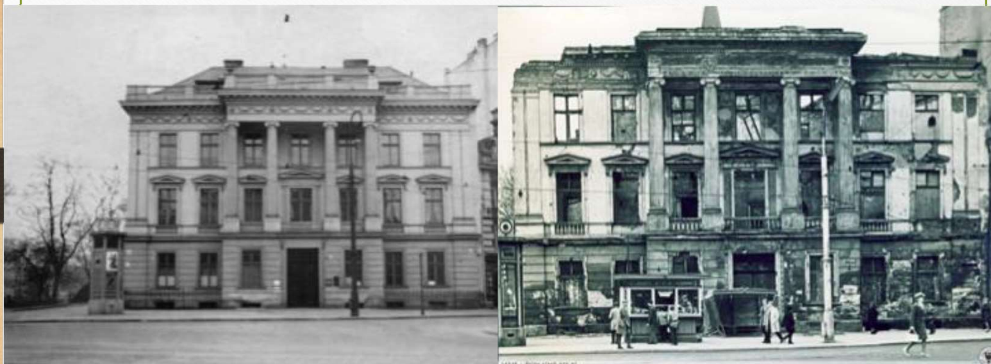
Budynek Banku Braci Aleksandrow Wrocław
