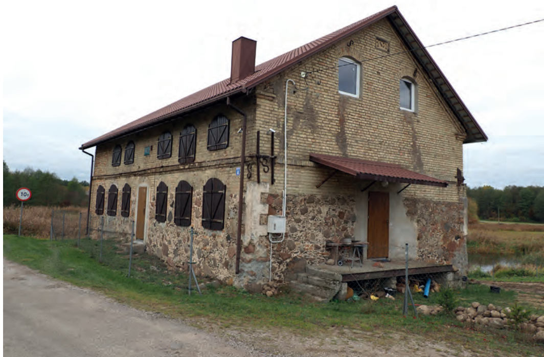
12. Siderka. Widok na młyn od pld.-wsch. Fot. A. Kułak, 2022 (w zbiorach NID OTB) Siderka. View of the mill from the southeast. Photo by A. Kułak, 2022 (in the collection of NID OTB)
