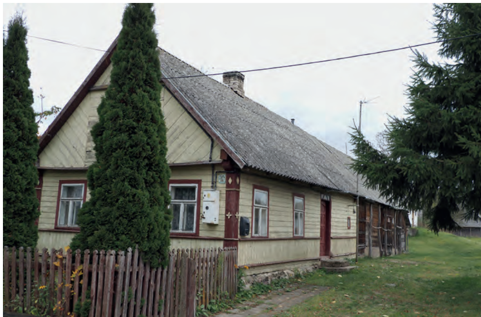
22. Siderka. Dom nr 23 w zagrodzie wydłużonej. Fot. I. Górską, 2022 (w zbiorach NID OTB) Siderka. House No. 23 in the elongated homestead. Photo by I. Górską, 2022 (in the collections of NID OTB)
