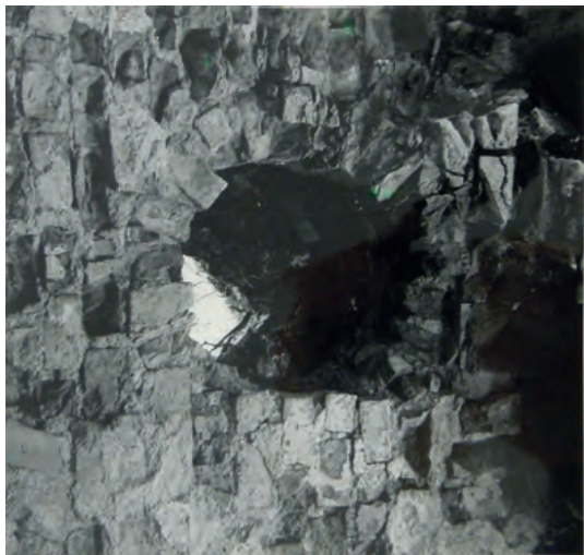
6. Supraśl, katakumby, otwór wentylacyjny w ścianie wschodniej. Fot. Z. Skrok, T. Wilde Supraśl, catacombs, ventilation opening in the eastern wall. Photo by Z. Skrok, T. Wilde
