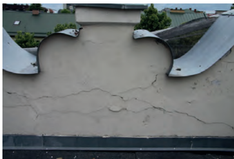
7 b. Miejsce odkrywki naturalnej 6. Zbliżenie Location of natural test pit no. 6 - close-up
