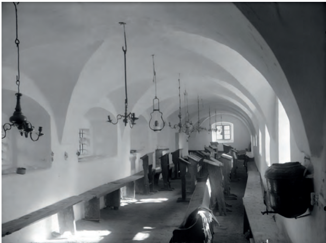
20. Synagoga w Tykocinie. Alkierz od strony zachodniej mieszczącej prawdopodobnie salę modlitewną dla kobiet, czyli babiniec ( ezrat naschim ), 1925. Po prawej przy wejściu widoczne naczynie do obmywania rąk kijor . Źródło: zbiory IS PAN w Warszawie, fot. S. Zajczyk The Synagogue in Tykocin. The alcove from the western side, likely housing the women's prayer hall, or babiniec ( ezrat naschim ), 1925. On the right near the entrance, a vessel for handwashing ( kijor ) is visible. Source: Collections of the Institute of Art of the Polish Academy of Sciences (IS PAN) in Warsaw, photo by S. Zajczyk
