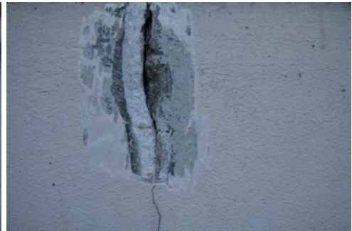
4 d. Miejsce wykonania odkrywki nr 3. Zbliżenie. Pod warstwą malatury wtórnej widoczne resztki oryginalnej warstwy malarskiej w kolorze ugrowym (żółcień) oraz oryginalny tynk w kolorze szarym Location of test pit no. 3 - close-up. Under the secondary paint layer, remnants of the original paint layer in yellow (ochre) and the original grey plaster are visible
