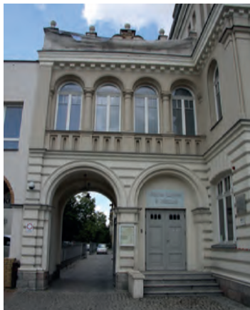
5 a. Miejsce odkrywki naturalnej Location of the natural test pit
