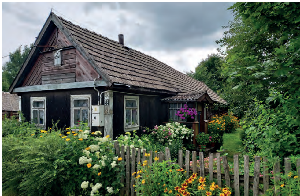
20. Siderka. Dom nr 58 w zagrodzie wydłużonej. Fot. I. Górską, 2022 (w zbiorach NID OTB) Siderka. House No. 58 in the elongated homestead. Photo by I. Górską, 2022 (in the collections of NID OTB)
