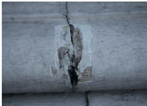
3 e. Pod warstwą malatury wtórnej widoczne resztki oryginalnej warstwy malarskiej w kolorze ugrowym (żółcień) oraz oryginalny tynk w kolorze szarym. Na tej odkrywce wyraźnie widać, że były dwie warstwy wtórne malatur: wierzchnia warstwa w kolorze écru oraz warstwa pod nią w kolorze szarym Under the secondary paint layer, remnants of the original paint layer in yellow (ochre) and the original grey plaster are visible. This test pit clearly shows two secondary paint layers: the outer layer in ecru and a layer beneath it in grey
