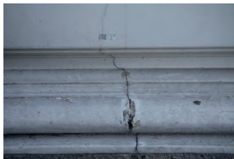
3 b. Miejsce wykonania odkrywki nr 2. Zbliżenie Location of test pit no. 2 - close-up
