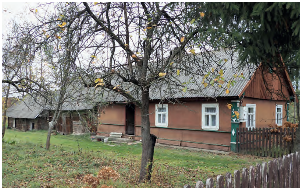
23. Siderka. Dom nr 29 z budynkami gospodarczymi wzdłuż siedliska. Fot. I. Górską, 2022 (w zbiorach NID OTB) Siderka. House No. 29 with farm buildings along the homestead. Photo by I. Górską, 2022 (in the collections of NID OTB)
