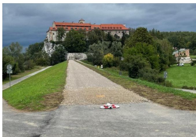
Zadanie 2 – widok po realizacji
