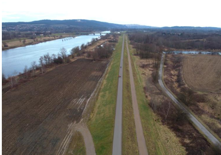
Zadanie 3 – widok po realizacji
