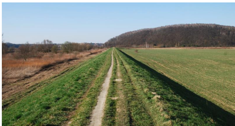
Zadanie 1 – widok przed realizacją
