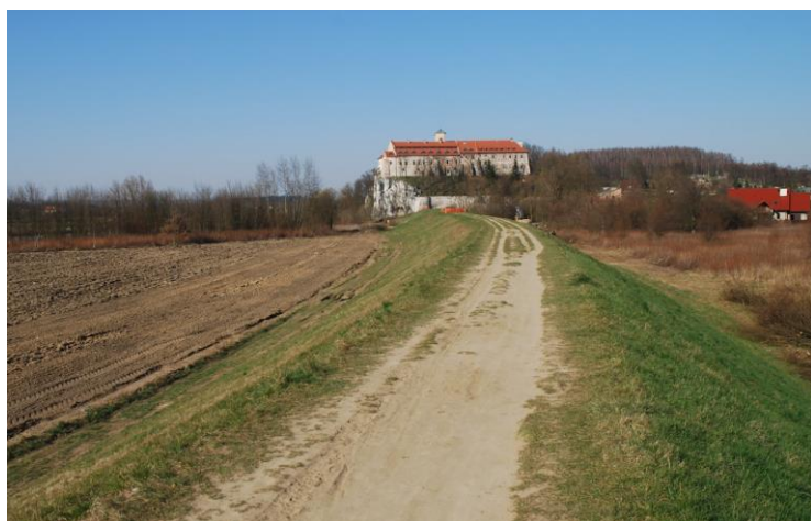
Zadanie 2 – widok przed realizacją
