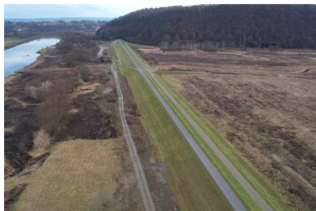
Zadanie 1 – widok po realizacji
