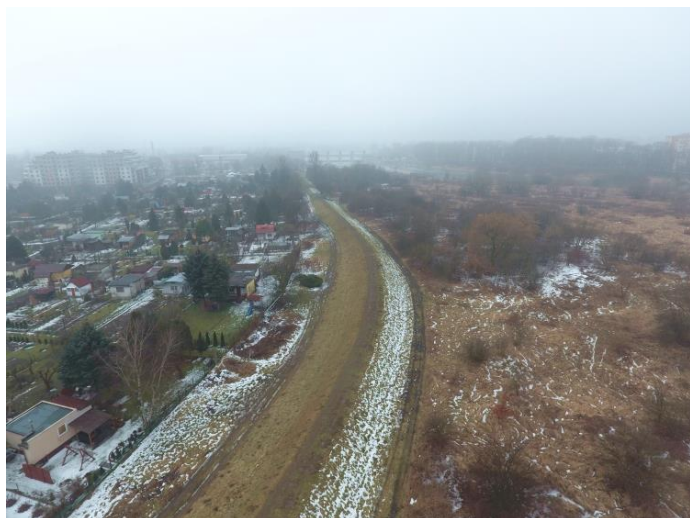
odcinek 3.1 – widok przed realizacją
