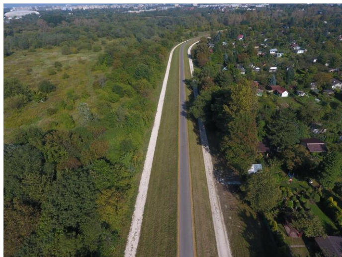
odcinek 3.1 – widok po realizacji
