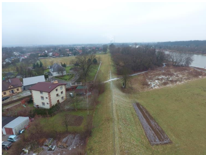
odcinek 3.3 – widok przed realizacją
