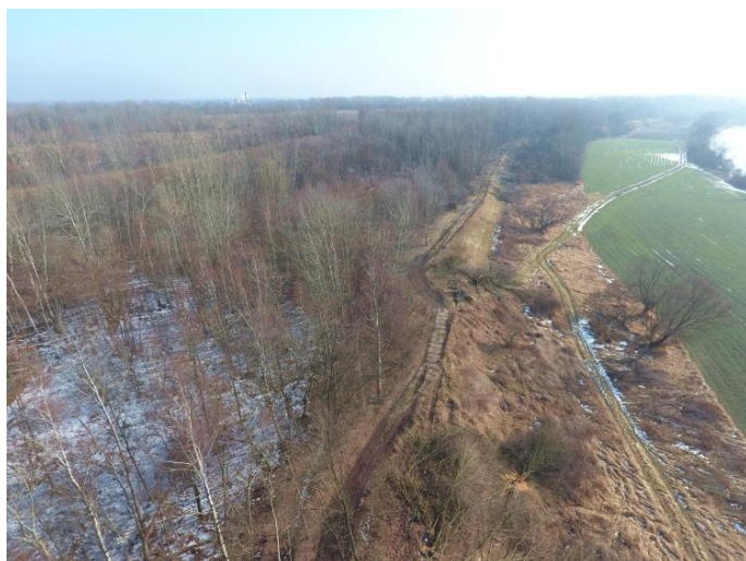
odcinek 1.3 – widok przed realizacją
