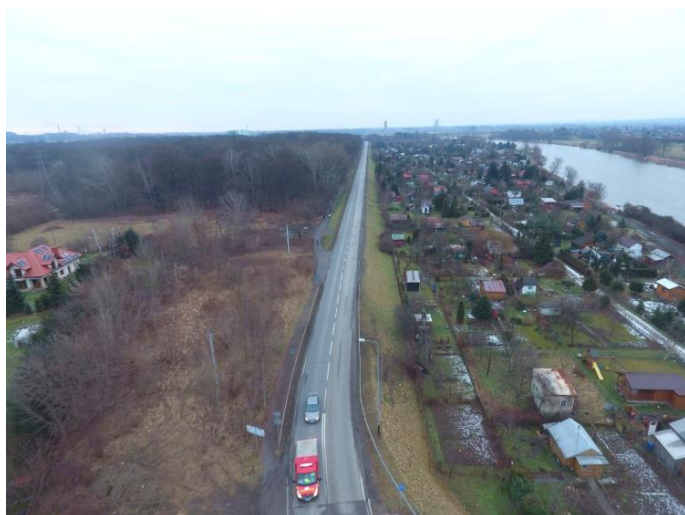
odcinek 1.1 – widok przed realizacją
