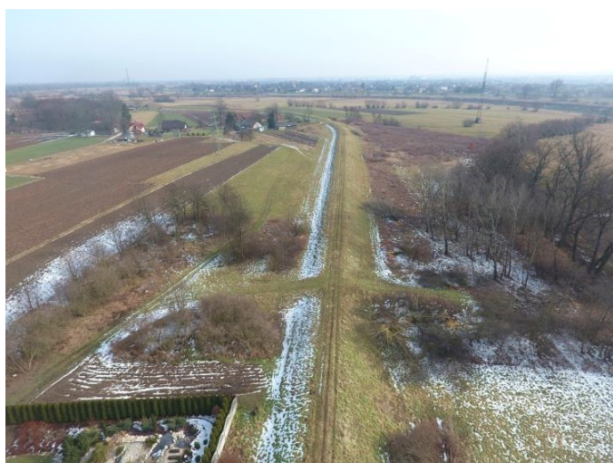
odcinek 2 – widok przed realizacją
