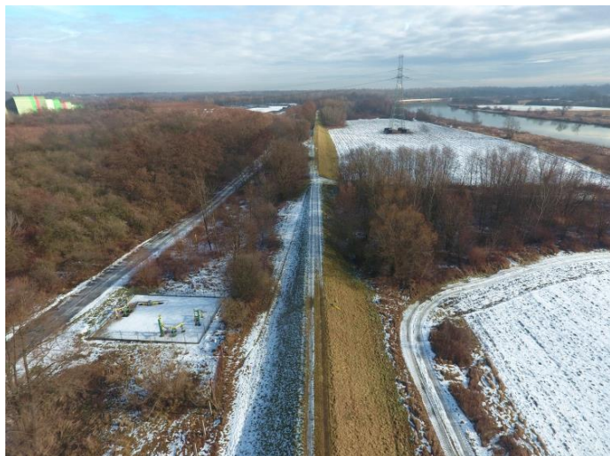
odcinek 1.2 – widok przed realizacją
