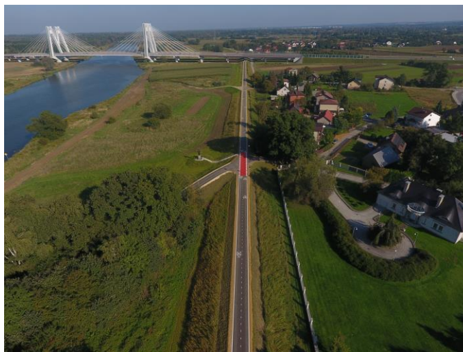
odcinek 3.3 – widok po realizacji
