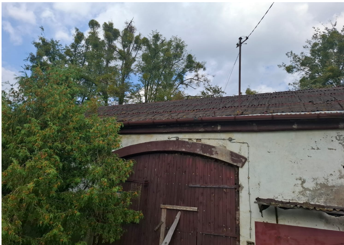
Fot. 1 Elewacja frontowa
