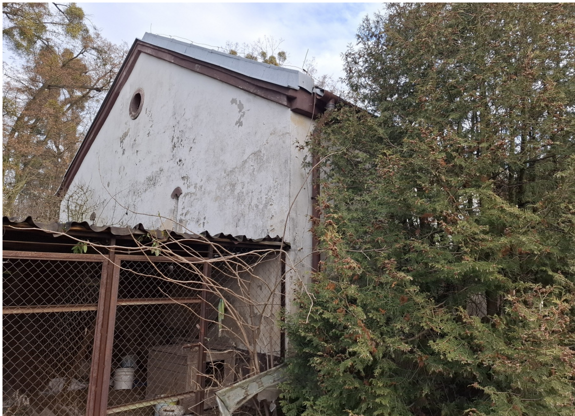
Fot. 3 Elewacja tylna
