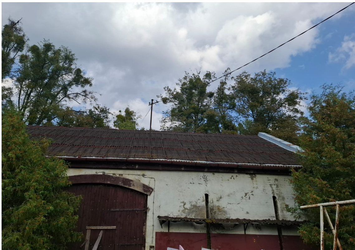
Fot. 2 Elewacja frontowa
