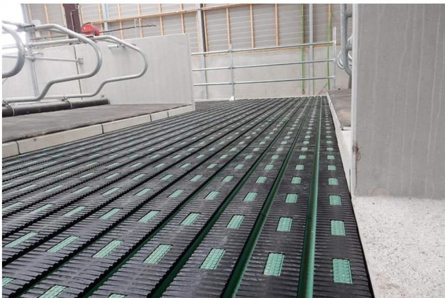
Fot. 3. System z podłogą szczelinową rowkową
