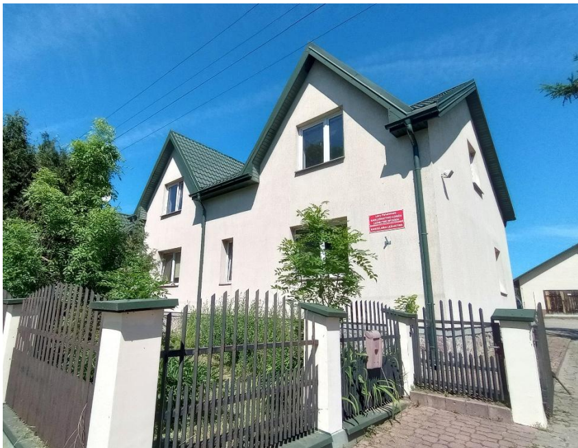
Fot. 1 Budynek mieszkalny elewacja frontowa
